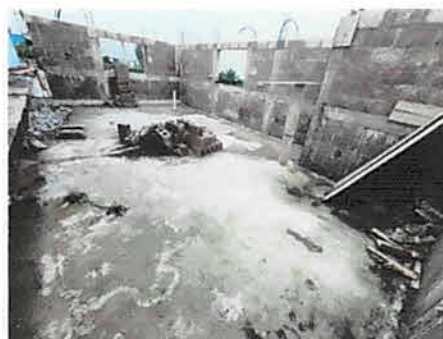
Mantenimiento correctivo sustitución de piso de torta de cemento por cerámica, módulo 3, segundo piso
