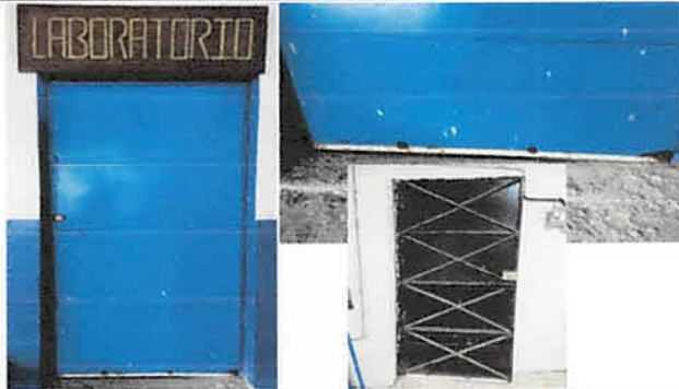
Sustitución de puerta metal aula laboratorio, módulo I, piso 1.
