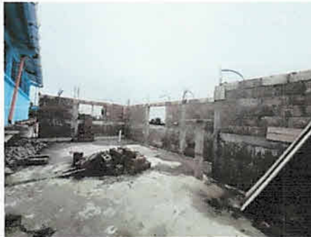
Suministro e instalación estructura metálica, módulo 3, segundo piso
