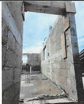
Suministro e instalación de puerta metálica, módulo 3, segundo piso
