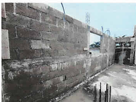
Mantenimiento correctivo a paredes con repello, módulo 3, segundo piso
