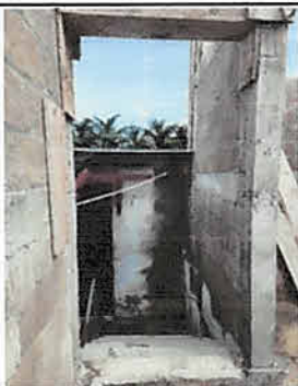
Suministro e instalación de reja metálica de seguridad para puerta, módulo 3, segundo piso
