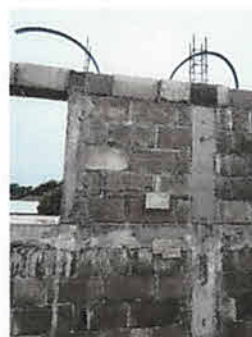
Mantenimiento correctivo suministro e instalación de cableado eléctrico, módulo 3, segundo piso
