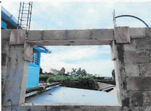
Suministro e instalación de ventanas PVC, módulo 3, segundo piso
