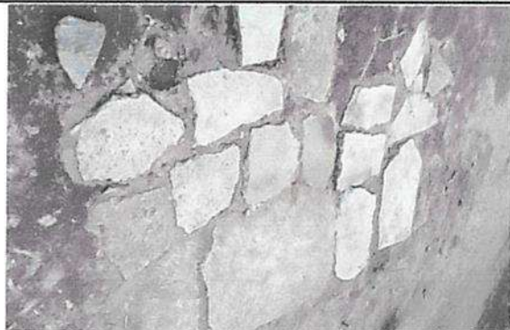
Sustitución de piso de concreto de patio.
