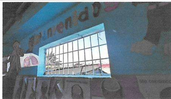
Suministro e instalación de ventana de aluminio en 3 aulas del módulo 3 y dirección del establecimiento educativo.
