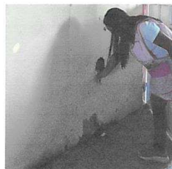
Sustitución muro de plywood para división de 3 aulas en módulo 3
