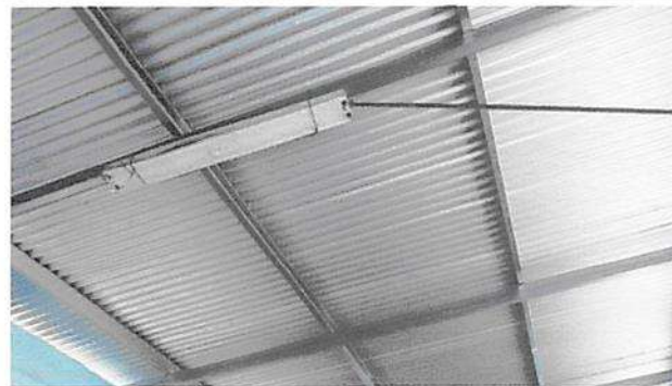
Suministro e instalación de cableado eléctrico en tres módulos 12 aulas.
