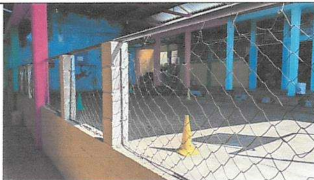
Sustitución de cerca de seguridad de malla galvanizada en cancha deportiva.
