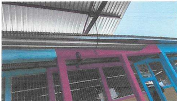
Suministro e instalación de bajada pluvial en módulo 2 y 3
