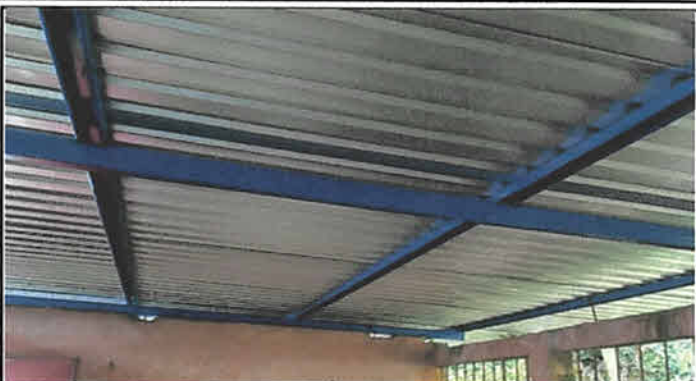
Sustitución de estructura de soporte de madera por metal en cocina 40 mts2
