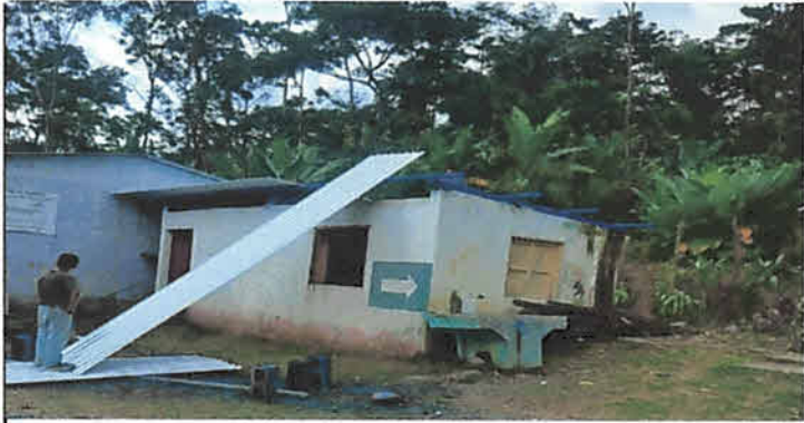
Sustitución de lámina por lámina troquelada calibre 26 en cocina 40 mts2
