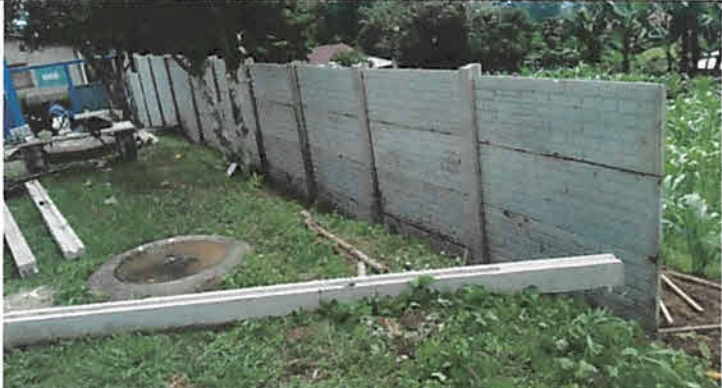
Sustitución de muro perimetral con barda prefabricada de concreto h=2.50m (concreto reforzado) 140 mts2
