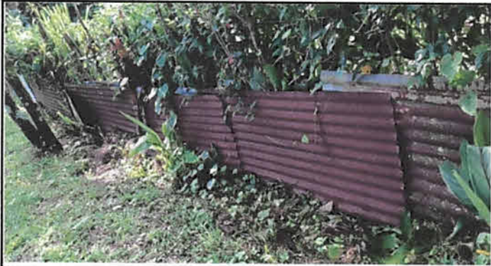
sustitucion de muro perimetral con barda prefabricada de concreto h=2.50m (concreto reforzado) 140 mts2
