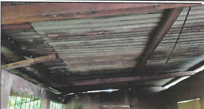
Sustitución de estructura de soporte madera por metal en cocina 40 mts2
