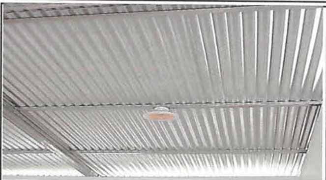
Sustitución de lámina troquelada por lámina acanalada calibre 26 en módulo 1. 60 m2
