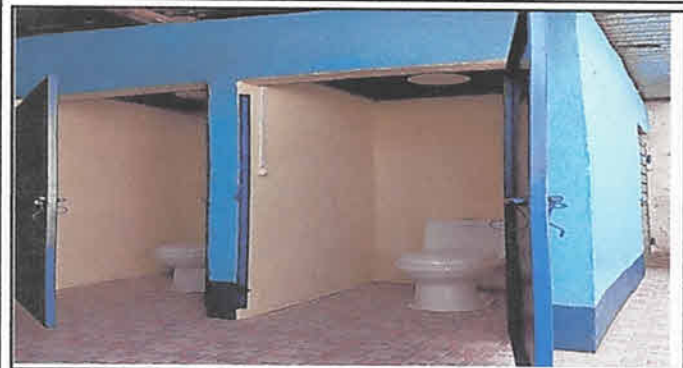
Sustitución de sanitarios de un solo cuerpo doble descarga 2 unidades; Sustitución de puertas para servicio sanitario de doble seguro 2 unidades; Mantenimiento e instalación de piso cerámico en servicios sanitarios 6 m2; Mantenimiento de paredes de servicios sanitarios repello y pintura 32m2; Instalación de cielo falso con iluminarias de servicios sanitarios 2 unidades
