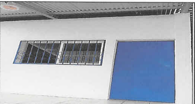
Sustitución de puerta principal Modulo 1, 1 unidad; Sustitución de ventanas a PVC corredizas modulo 1 de 1.04x1.75 metros 2 unidades; Sustitución de balcones metálicos módulo 1 de 1.04 x 1.75 metros 2 unidades
