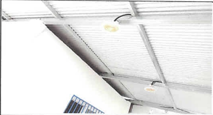
Sustitución de estructura metálica de soporte del techo en modulo 1 36 m2 y Sustitución de estructura metálica soporte de paredes en modulo 1 24 ml
