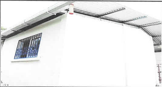
Mantenimiento y sustitución de repello de paredes exterior módulo 1. 80 m2
