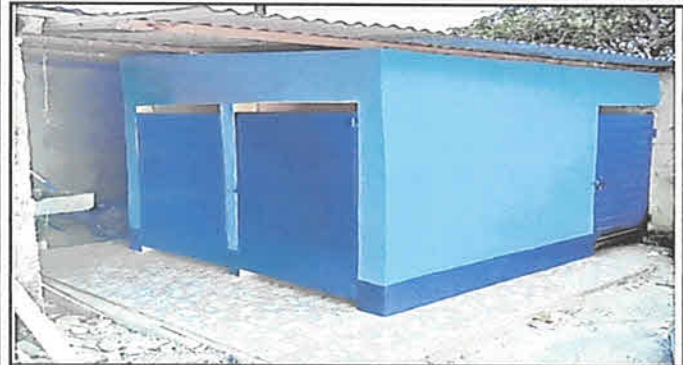
Sustitución de piso de cemento a cerámico en servicios sanitarios 6 m2; Mantenimiento de paredes de servicios sanitarios repello y pintura 32m2; Instalación de cielo falso con iluminarias de servicios sanitarios 2 unidades
