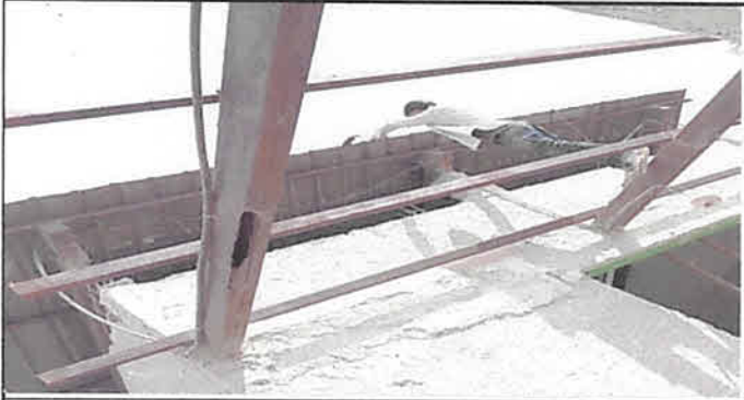
Sustitución estructura metálica de soporte del techo en modulo 1 36 m2 y Sustitución de estructura metálica de soporte de paredes en modulo 1 24 ml
