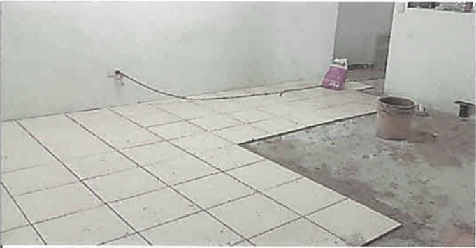
Mantenimiento y sustitución de piso cerámico para módulo 1, 36 m2
