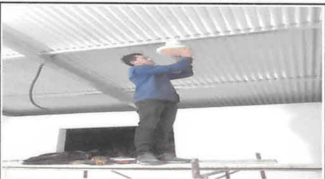
Sustitución de red eléctrica Módulo 1 40 ml, Sustitución de Cable 10AWG para red eléctrica modulo 1 y S.S. 80 ml, Mantenimiento correctivo con forro Industrial de aislamiento para red eléctrica 40 ml, Sustitución de lámparas de techo para sobreponer tipo led en modulo 1 y S.S 5 unidades
