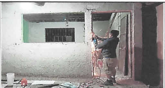
Sustitución de puerta principal Módulo 1, 1 unidad; Sustitución de ventanas a PVC corredizas modulo 1 de 1.04x1.75 metros 2 unidades; Sustitución de balcones metálicos módulo 1 de 1.04 x 1.75 metros 2 unidades
