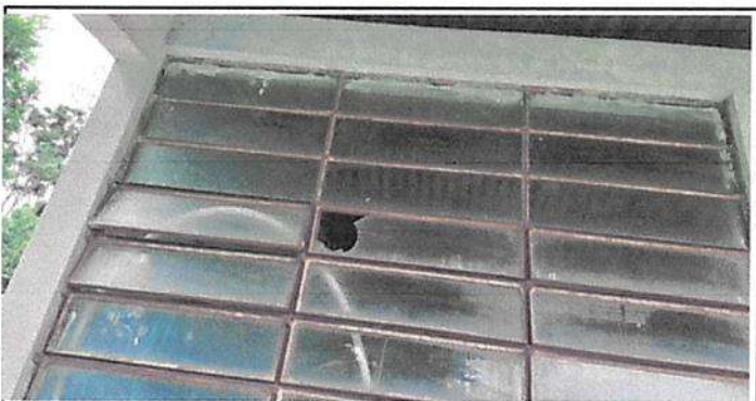
Sustitucion de ventas tipo U-PVC
