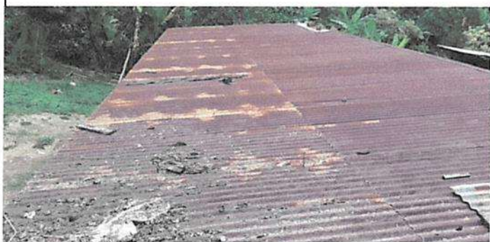
Sustitucion de lamina, por lamina troquelada calibre 26
