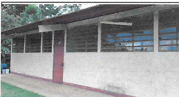
Suministro y aplicación de pintura exterior e interior azul pantone 296 para muros
