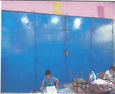
Sustitución de muro
