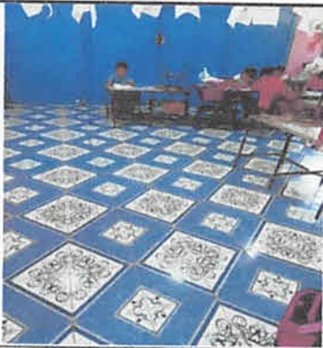
Mantenimiento y nivelación de piso existente en módulo 1
