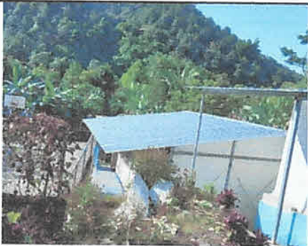
Suministro e instalación de estructura
