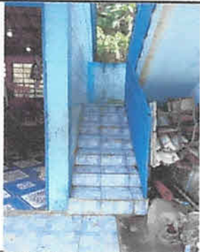
Suministro e instalación de piso cerámico antideslizante con conexión a gradas del módulo del segundo nivel.
