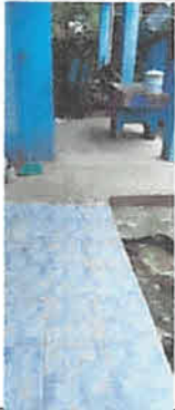
Suministro e instalación de piso cerámico antideslizante en corredor de modulo 1
