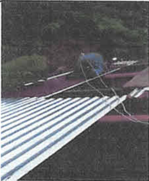
Suministro e instalación de lamina cal. 26 módulo 5
