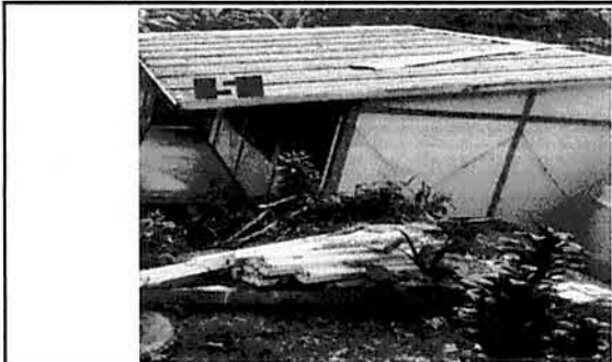
Suministro e Instalación de Láminas Cal, 26 de 9.50 Mts de largo x 11 Mts de Ancho en Módulo 5
