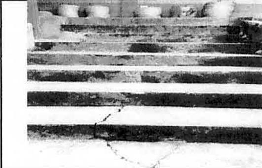
Suministro e Instalación de Piso Cerámico Antideslizante Y Entechado con conexión a Módulo 5
