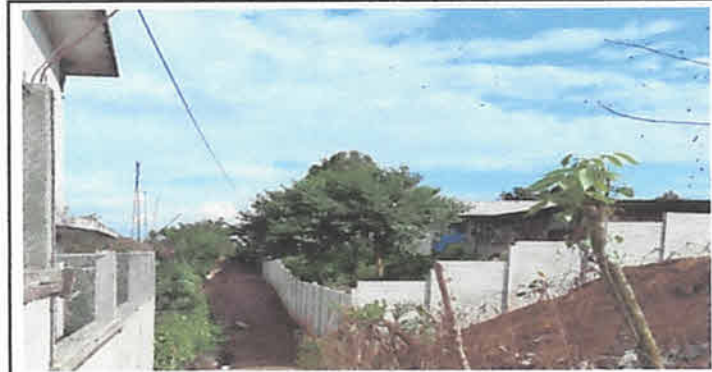
SUTITUCIÓN DE MURO PERIMETRAL CON BARDA PREFABRICADA DE CONCRETO H = 2.50 M (CONCRETO REFORZADO) 147 M2
