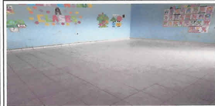
SUMINISTRO E INSTALACION DE 36 MTS2 DE PISO CERAMICO Y 24 MTS LINEALES DE ZOCALO
