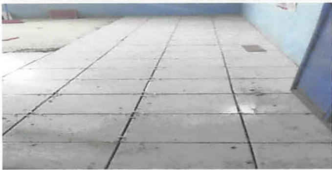
SUMINISTRO E INSTALACION DE 36 MTS2 DE PISO CERAMICO Y 24 MTS LINEALES DE ZOCALO
