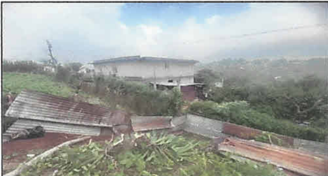
SUTITUCIÓN DE MURO PERIMETRAL CON BARDA PREFABRICADA DE CONCRETO H = 2.50 M (CONCRETO REFORZADO) 147 M2
