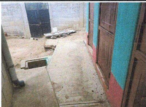
Sustitución de tubería para agua potable de inodoros, demolición y reposición de piso y banqueta existente., Sustitución de tubería de drenaje pluvial, sanjeado, relleno, compactación de suelo
