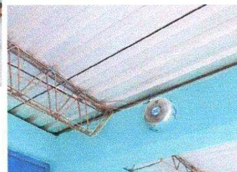
Suministro y sustitución de dos timbres que incluye ducto y cableado
