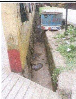
Revestimiento de cuneta existente de tierra, con concreto reforzado
