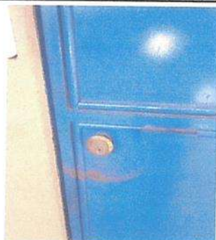
MANTENIMIENTO DE 2 PUERTAS + SUMINISTRO Y APLICACIÓN DE PINTURA DE ACEITE A TODAS LAS PUERTAS.
