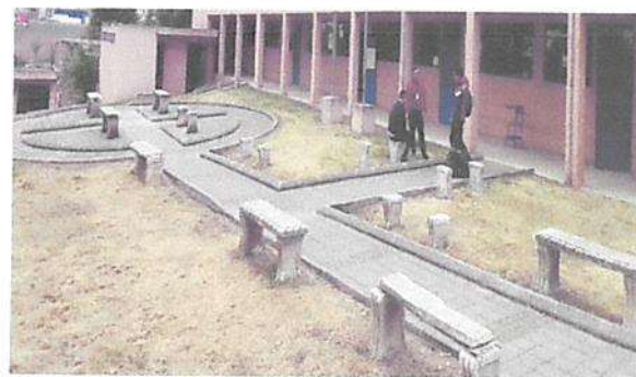
SUMINISTRO E INSTALACIÓN DE ASIENTOS DE CONCRETO PARA BANCAS EXISTENTES EN AREA VERDE CAMBIO DE ASIENTOS DE CONCRETO DE BANCAS
