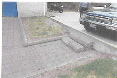
GRADAS DE ACCESO + INSTALACION DE PASAMANOS METALICO
