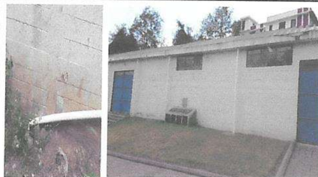
CAMBIO DE BAJADA DAÑADO, CAMBIO DE VIDRIOS DAÑADOS Y SUMINISTRO Y APLICACIÓN DE PINTURA A 2 PORTONES DE INGRESO, EN EL MODULO DEL SALON
