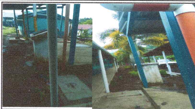
SUSTITUCION DE BAJADA PLUVIAL
