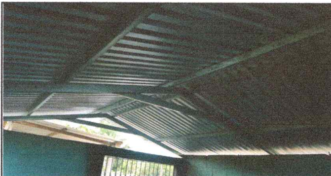
SUSTITUCION DE SOPORTE DE MADERA POR METAL
