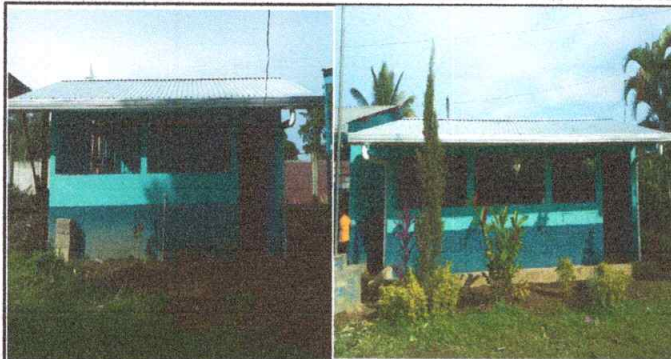
SUSTITUCION DE LAMINA POR LAMINA TROQUELADA
