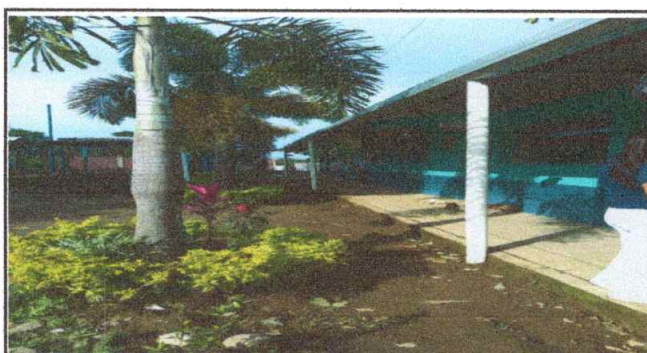
SUSTITUCION CANAL PVC
