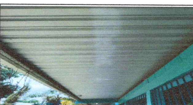
SUSTITUCION DE CANAL PVC
