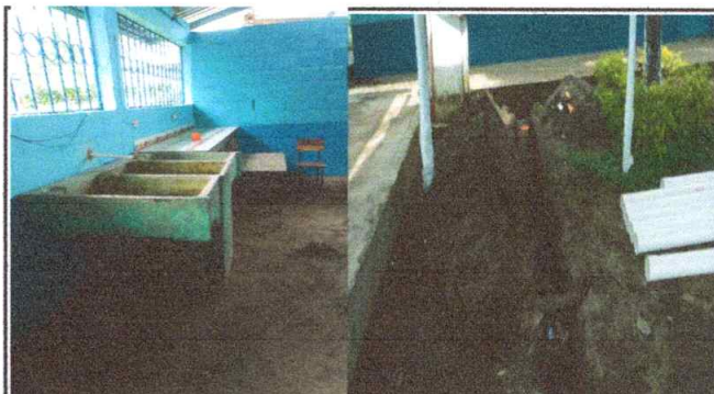
SUSTITUCION DE TUBERIA LINEA PRINCIPAL
