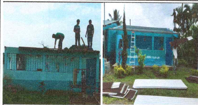
SUSTITUCION DE LAMINA POR LAMINA TROQUELADA
