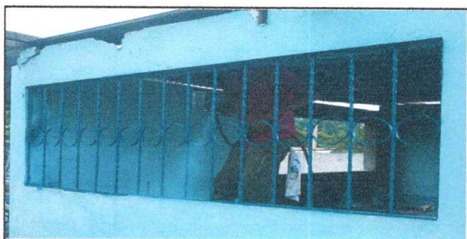
MANTENIMIENTO DE BALCONES
