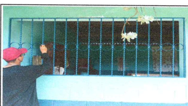
SUSTITUCION DE BALCONES
