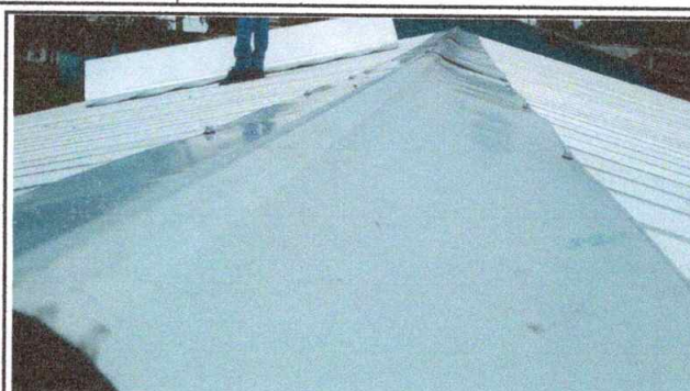
SUSTITUCION DE CAPOTE DE LAMINA PARA LAMINA TROQUELADA
