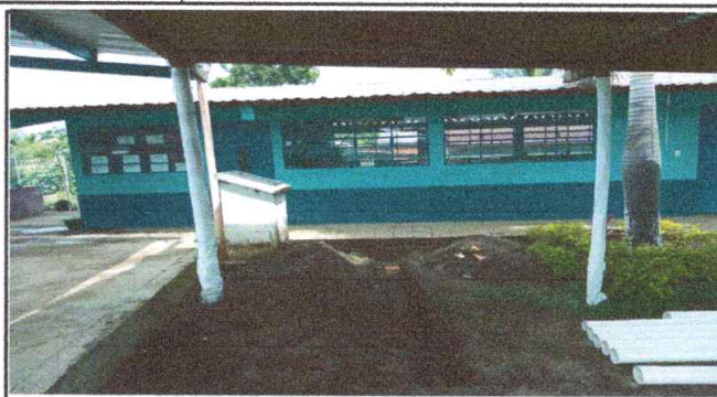
SUSTITUCION DE BAJADA PLUVIAL
