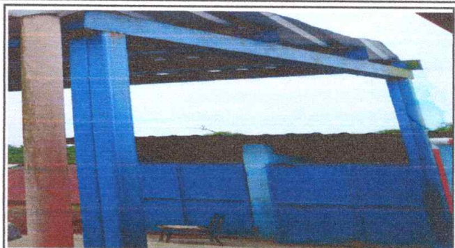
SUSTITUCION DE BAJADA DE AGUA PLUVIAL
