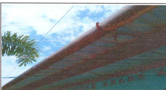
SUSTITUCION DE CANAL PVC
