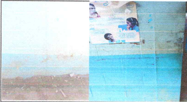
PINTURA EN MUROS EXTERIORES E INTERIORES
