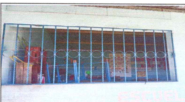
SUSTITUCION DE BALCONES DE METAL
