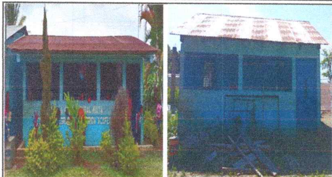
SUSTITUCION DE LAMINA POR LAMINA TROQUELADA
