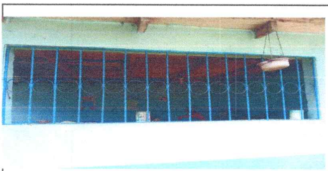
MANTENIMIENTO DE BALCONES
