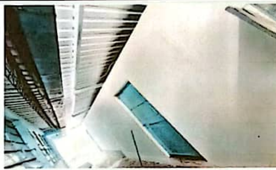
Sustitución de paredes de lámina por paneles prefabricados tipo durock.
