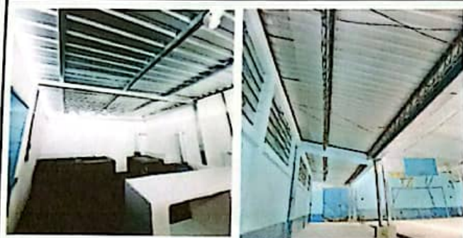
Suministro de materiales y mano de obra para la sustitución de cubierta de lámina troquelada Calibre 26 en cocina y corredor de módulo 1
