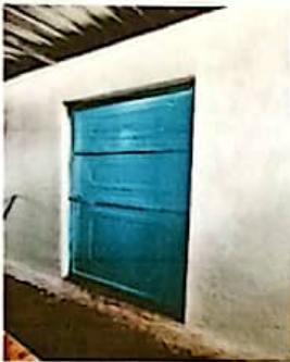
Sustitución de puerta Metálica de 2.10 por 1.00 con chapa yale.
