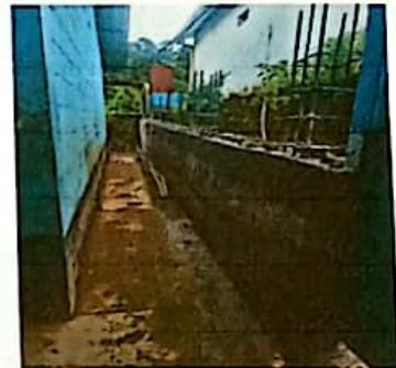
Mantenimiento correctivo de muro de retención de concreto de 30 cm. de grosor x 1.00 metro de altura.
