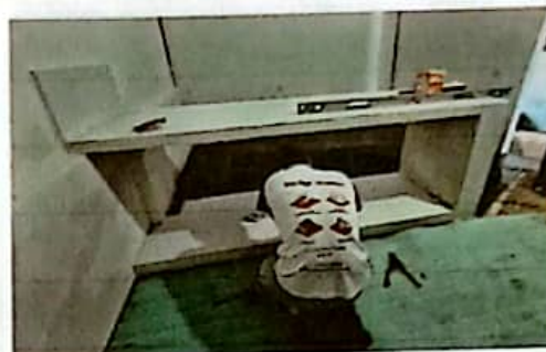
Sustitución de azulejo blanco en mesa de trabajo en cocina.
