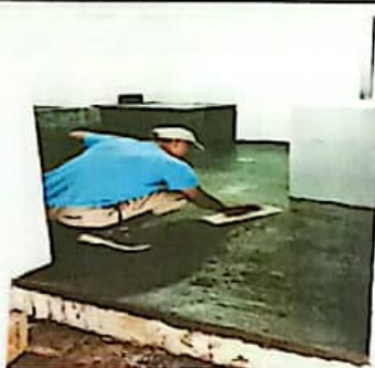
Sustitución de piso liso de Cemento en cocina.
