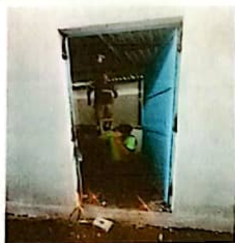
Sustitución de puerta Metálica de 2.10 por 1.00 con chapa yale.
