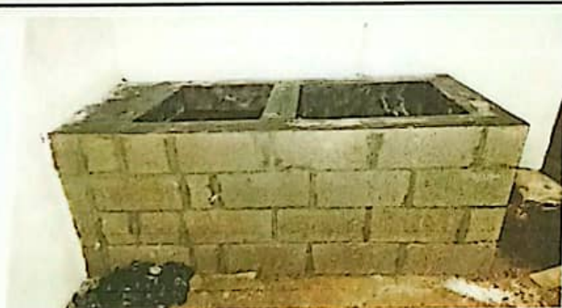
Sustitución de pila en cocina.
