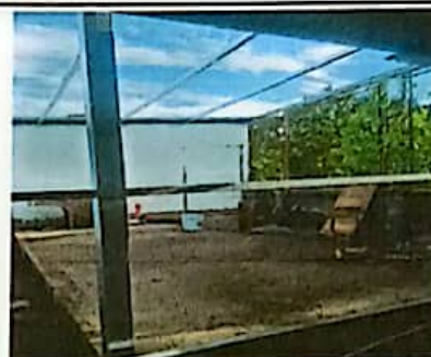
Sustitución de cubierta de estructura Metálica en cocina.
