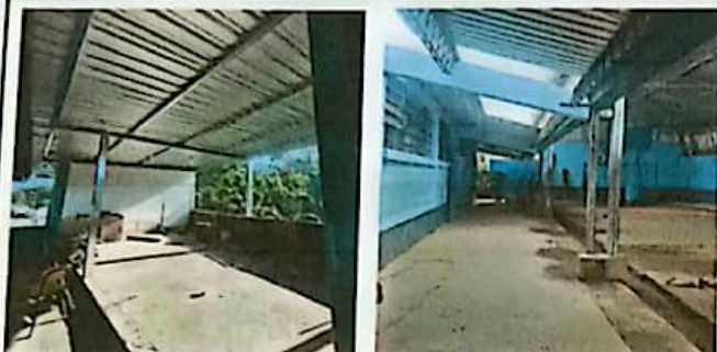
Suministro de materiales y mano de obra para la sustitución de cubierta de lámina troquelada Calibre 26 en cocina y corredor de módulo 1
