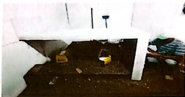
Sustitución de mesa de trabajo de concreto de 2 mts de largo x 0.90 de alto x 0.60 de frente en cocina.
