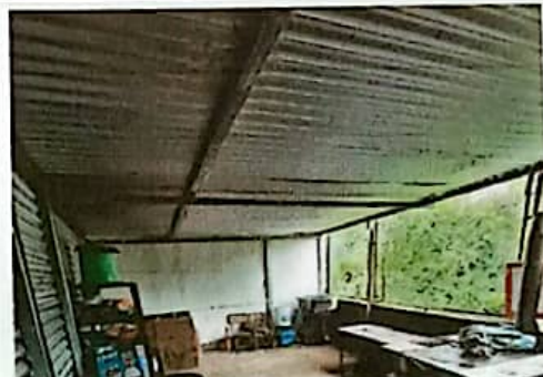
Sustitución de cubierta de estructura Metálica en cocina.
