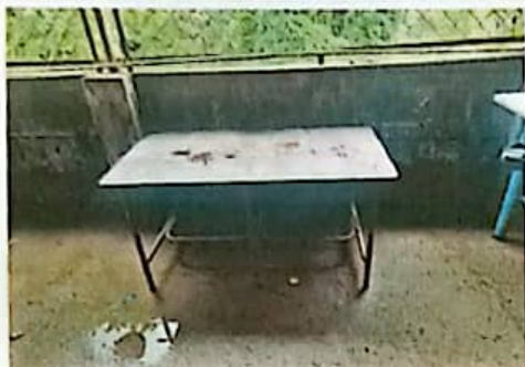
Sustitución de mesa de trabajo de concreto de 2 mts de largo x 0.90 de alto x 0.60 de frente en cocina.
