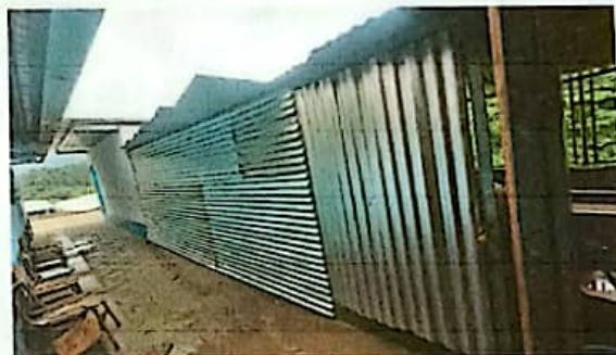
Sustitución de paredes de lámina por paneles prefabricados tipo durock.
