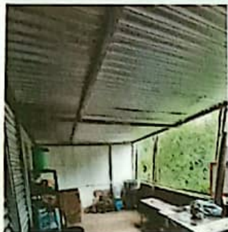
Suministro de materiales y mano de obra para la sustitución de cubierta de lámina troquelada Calibre 26 en cocina y corredor de módulo 1
