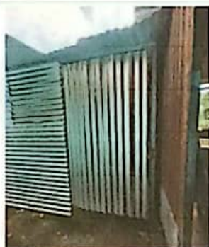
Sustitución de puerta Metálica de 2.10 por 1.00 con chapa yale.
