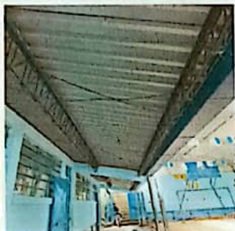
Suministro de materiales y mano de obra para la sustitución de cubierta de lámina troquelada Calibre 26 en cocina y corredor de módulo 1
