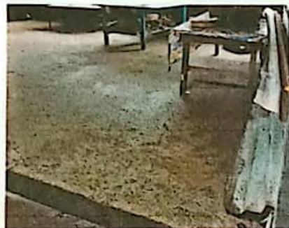
Sustitución de piso liso de Cemento en cocina.
