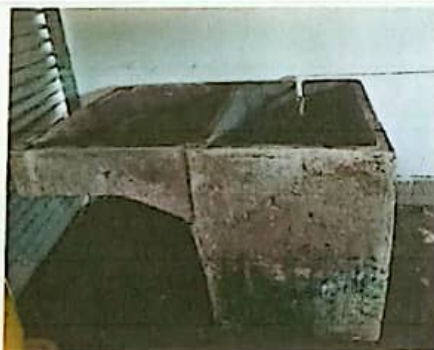
Sustitución de pila en cocina.
