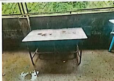
Sustitución de azulejo blanco en mesa de trabajo en cocina.
