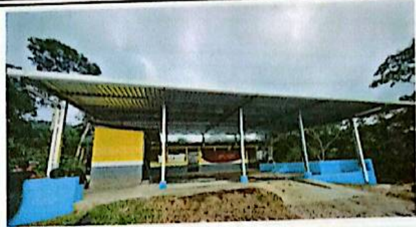
Sustitución de cubierta de estructura Metálica.
