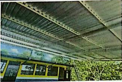
Sustitución de cubierta de lámina en área recreativa en un área de 120 metros cuadrados.
