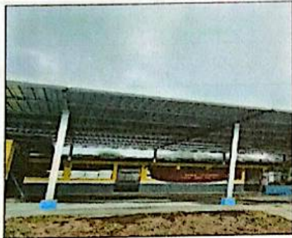
Sustitución de cubierta de estructura Metálica.
