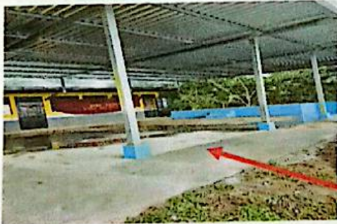
Sustitución de piso firme de concreto.
