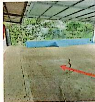
Sustitución de piso firme de concreto.
