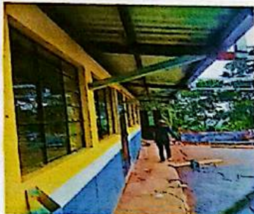
Sustitución de cubierta de lámina en área recreativa en un área de 120 metros cuadrados.
