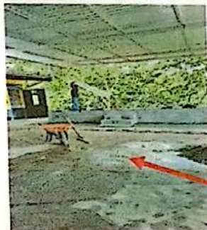
Sustitución de piso firme de concreto.
