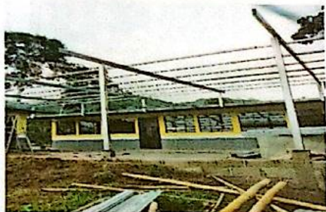
Sustitución de cubierta de estructura Metálica.
