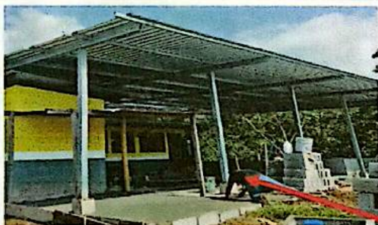
Sustitución de piso firme de concreto.
