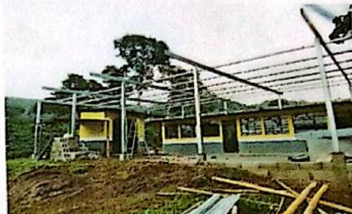
Sustitución de cubierta de estructura Metálica.
