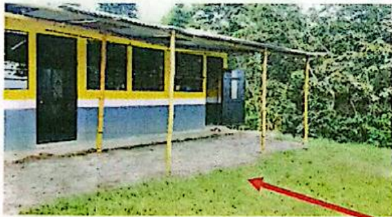
Sustitución de piso firme de concreto.
