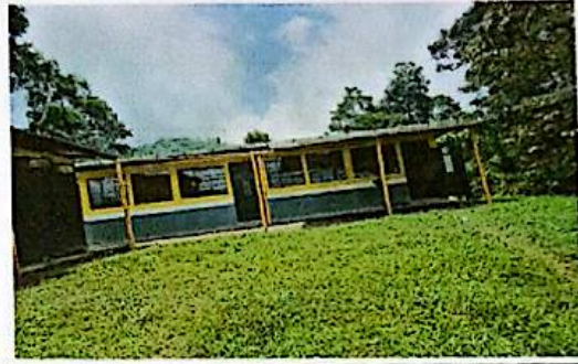
Sustitución de cubierta de estructura Metálica.
