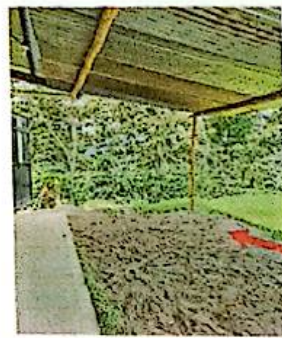
Sustitución de piso firme de concreto.
