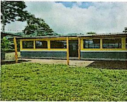
Sustitución de cubierta de estructura Metálica.
