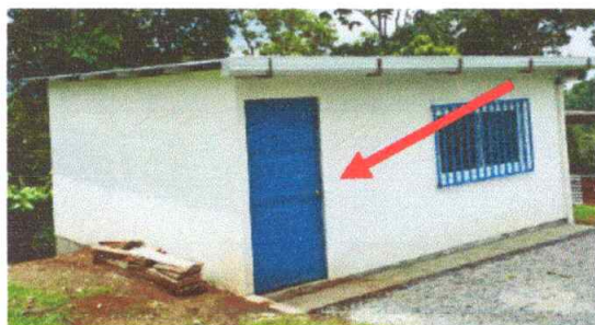
Foto 5: Sustitución puerta de metal.
