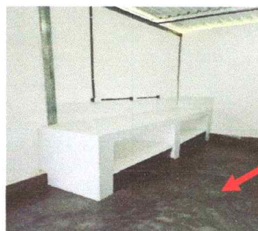
Foto 4: Sustitución de piso de concreto.
