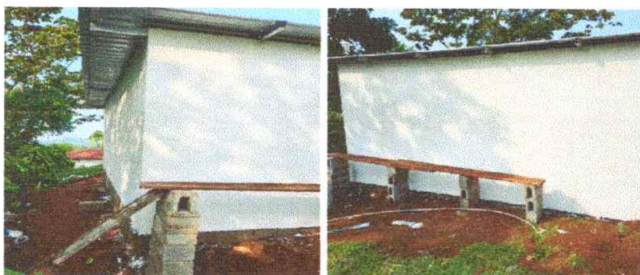
Foto1: Sustitución de Paneles prefabricados tipo duroc
