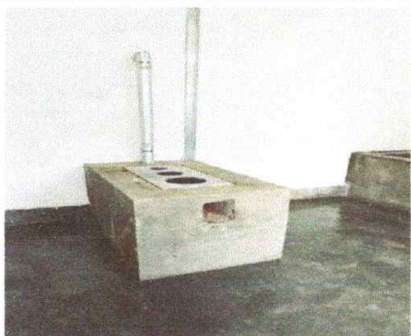
Foto 9: Sustitución de estufa de leña tipo polletón.
