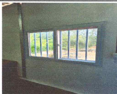
Foto 6: Sustitución de ventana PVC
