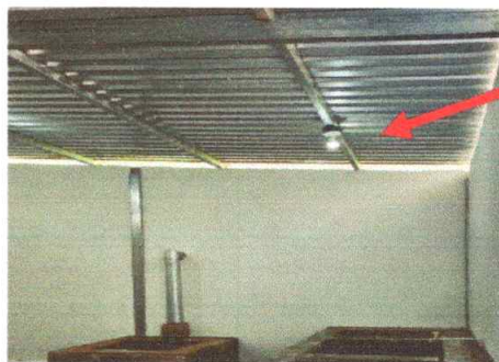
Foto 8: Sustitución de Red eléctrica
