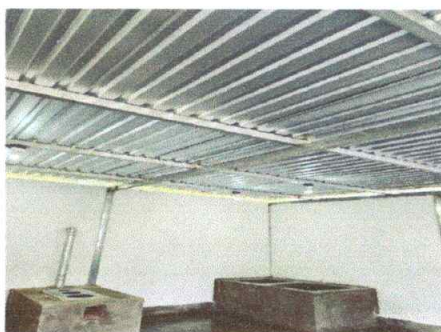
Foto 3: Sustitución de cubierta de techo de lámina.
