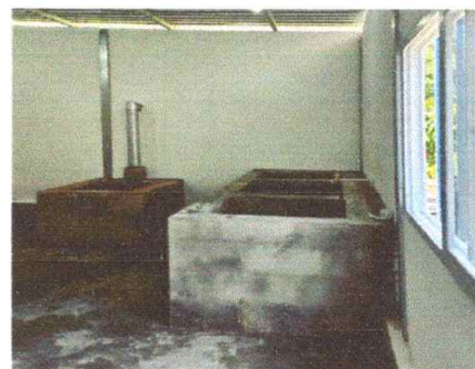
Foto 10: Sustitución de pila.
