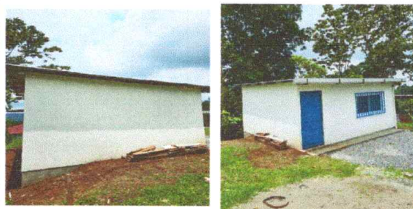
Foto 2: Sustitución de cubierta de estructura metálica
