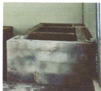
Foto 10: Sustitución de pila.
