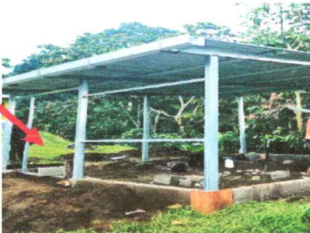
Foto 5: Sustrucción puerta de metal.
