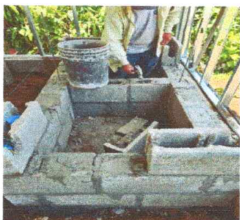
Foto 9: Sustitución de estufa de leña tipo polletón.
