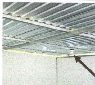
Foto 8: Sustitución de Red eléctrica
