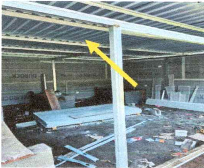
Foto 3: Sustrucción de cubierta de techo de lámina.
