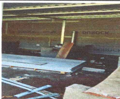
Foto 11: Sustitución de mesa de trabajo de concreto.
