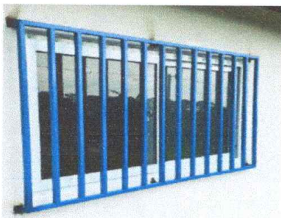
Foto7: Sustitución de balcón de metal.
