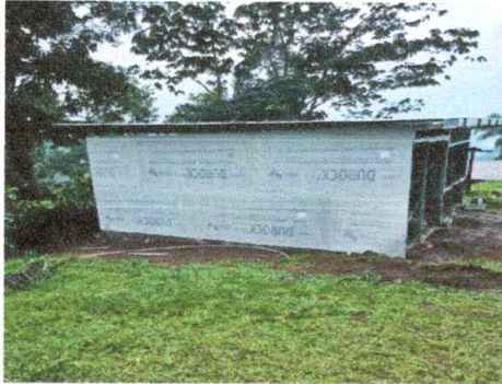
Foto1: Sustrucción de Paneles prefabricados tipo duroc
