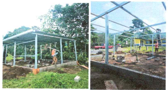
Foto 2: Sustrucción de cubierta de estructura metálica
