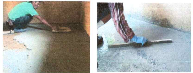
Foto 4: Sustrucción de piso de concreto.
