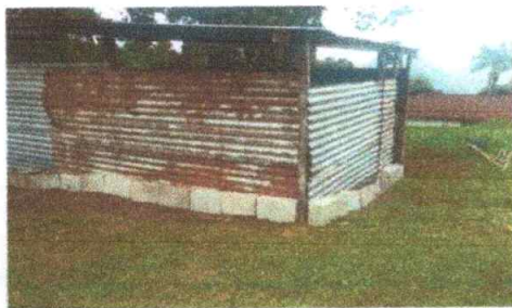
Sustitución de paneles prefabricados tipo duroc .
