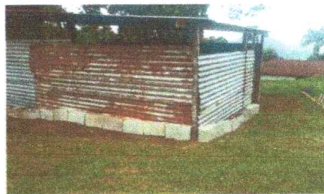
Sustitución de Cubierta de estructura Metálica
