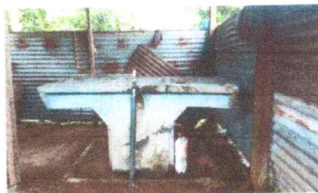
Sustitución de pila .
