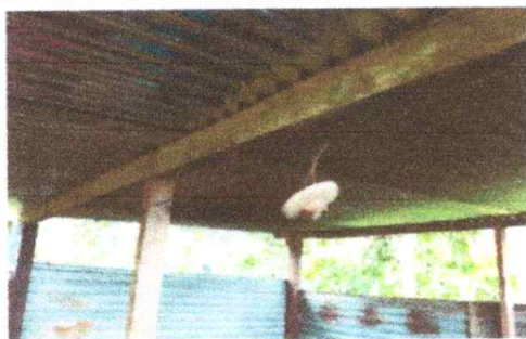
Sustitución de cubierta De techo de lámina
