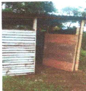
sustitución de puerta de metal
