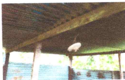
Sustitución de red eléctrica
