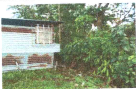
sustitución de balcón de metal.
