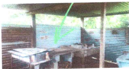
Sustitución de mesa de trabajo de Concreto.
