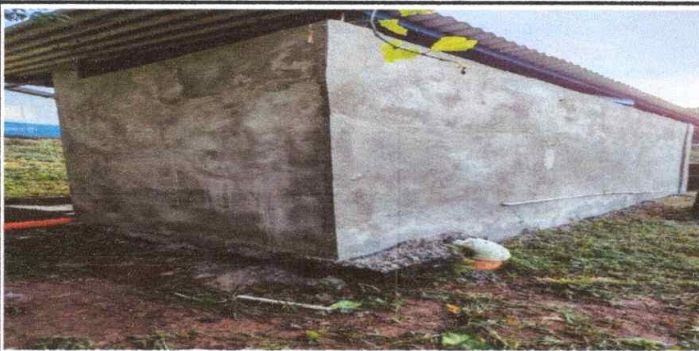
Foto 3: REPARACION DE PARED E SERVICIO SANITARIO
