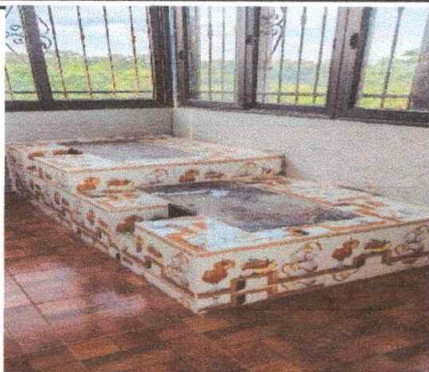
Foto 7: SUSTITUCION DE ESTUFA DE LADRILLO EN COCINA
