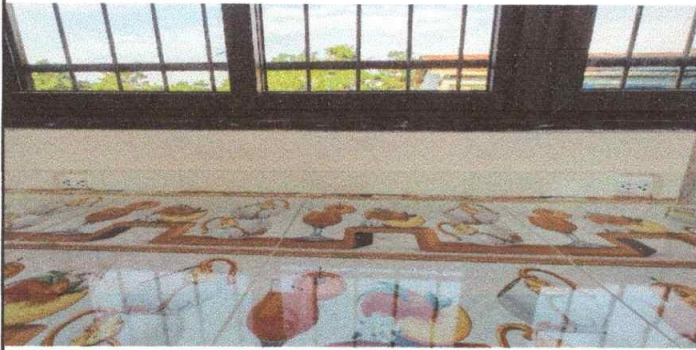
Foto13: SUSTITUCION DE CABLE ELECTRICO + TOBERIA PVC E3 ELECTRICA EN COCINA
