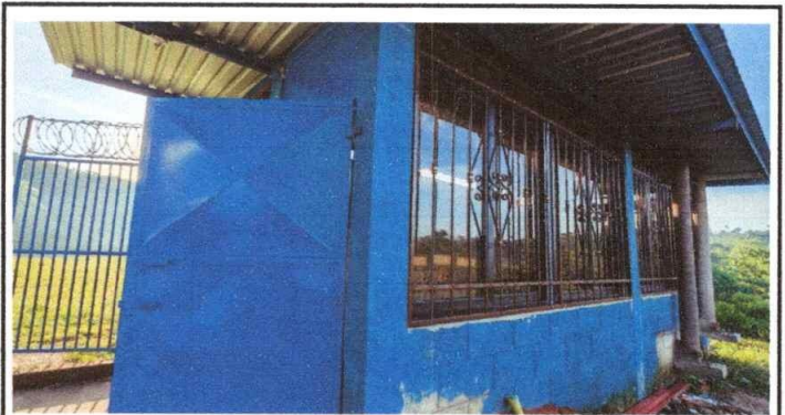
Foto 4: SUSTITUCION DE VENTANAS UPVC EN COCINA
