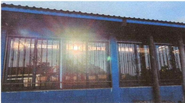
Foto 5: SUSTITUCION DE BALCONES METALICOS EN COCINA
