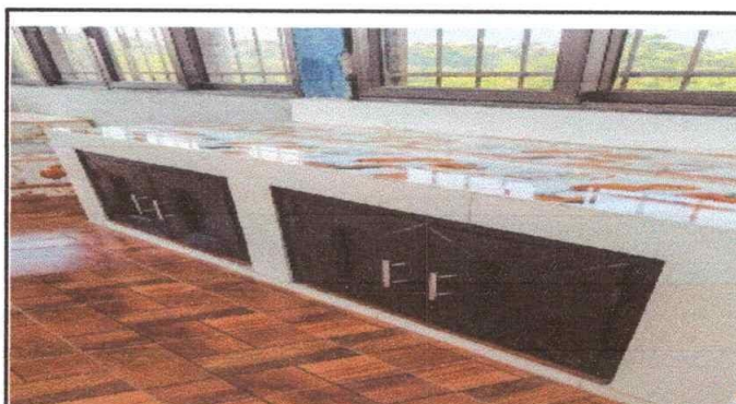
Foto 10: SUSTITUCION DE PUERTA UPVC EN GABINETES DE MESA DE TRABAJO
