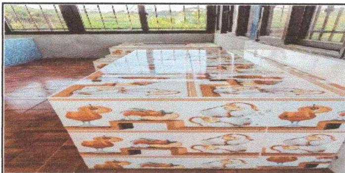
Foto 9: SUSTITUCION DE AZULEJO EN MESA DE CONCRETO
