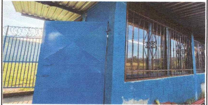
Foto 14: MANTENIMIENTO DE PUERTA METALICA EN LA COCINA
