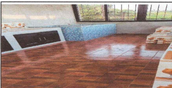
Foto 11: SUSTITUCION DE PISO CEREMACO EN COCINA
