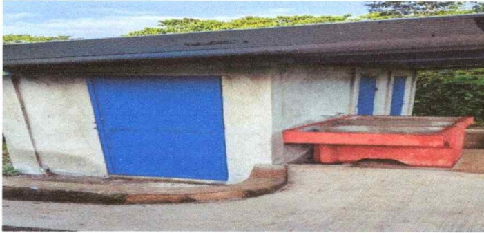
Foto1: SUSTITUCION DE PUERTA DE SERVICIO SANITARIO METALICO
