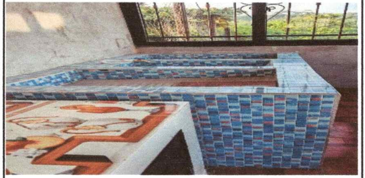
Foto 6: SUSTITUCION DE PILA CON DOS LAVADEROS
