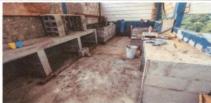
Foto 11: SUSTITUCION DE PISO CEREMACO EN COCINA
