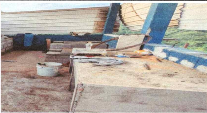
Foto 9: SUSTITUCION DE AZULEJO EN MESA DE CONCRETO
