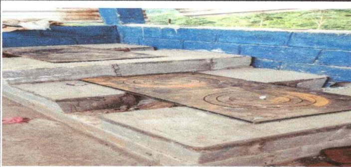
Foto 7: SUSTITUCION DE ESTUFA DE LADRILLO EN COCINA
