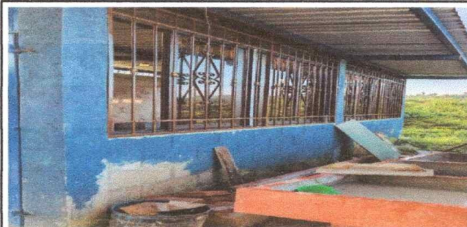
Foto 5: SUSTITUCION DE BALCONES METALICOS EN COCINA
