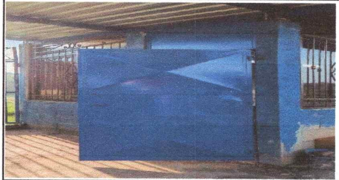
Foto 14: MANTENIMIENTO DE PUERTA METALICA EN LA COCINA
