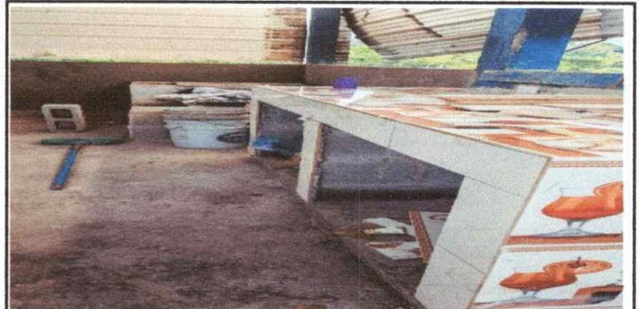
Foto 10: SUSTITUCION DE PUERTA UPVC EN GABINETES DE MESA DE TRABAJO
