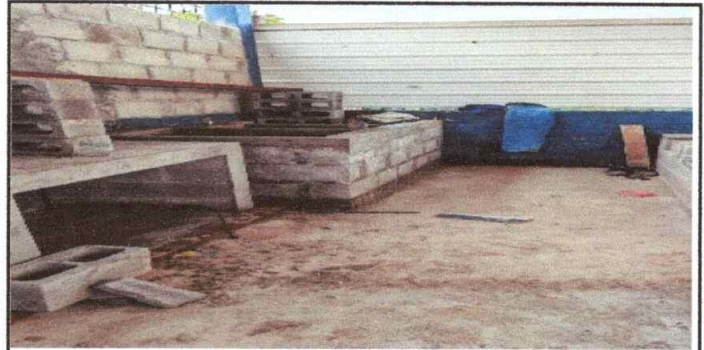
Foto 8: SUSTITUCION DE MESA DE CONCRETO EN COCINA
