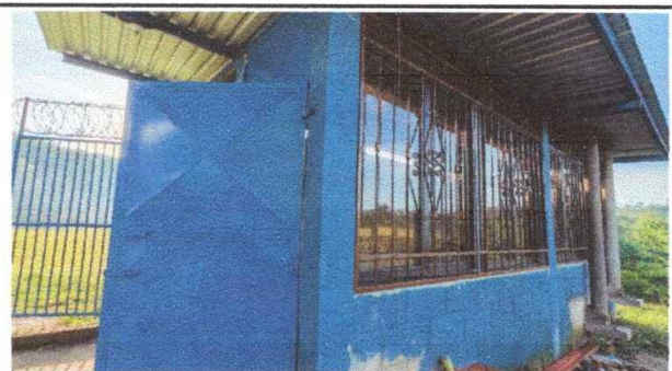
Foto 4: SUSTITUCION DE VENTANAS UPVC EN COCINA
