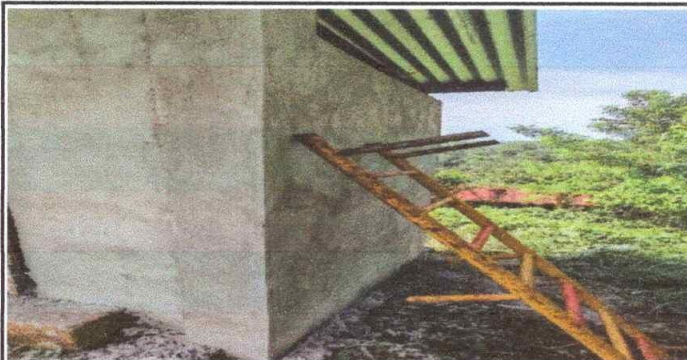
Foto 3: REPARACION DE PARED E SERVICIO SANITARIO
