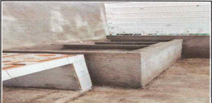
Foto 6: SUSTITUCION DE PILA CON DOS LAVADEROS
