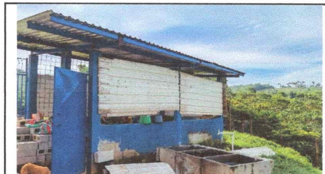
No.4 sustitución de ventanas UPVC en cocina
