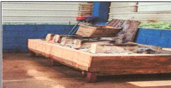
No.7 Sustitución de estufa de ladrillo en cocina
