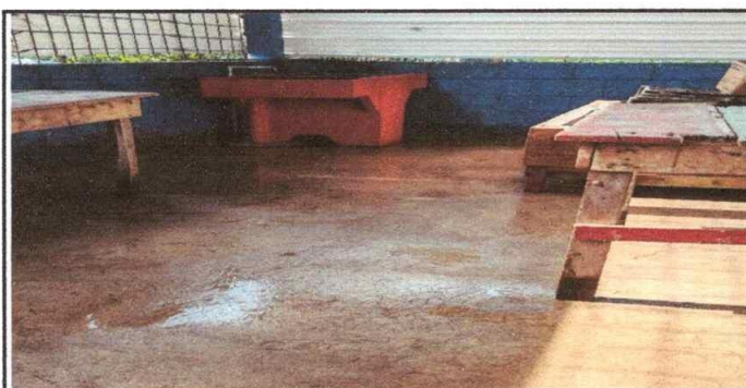
No.11 sustitución de piso cerámico en cocina
