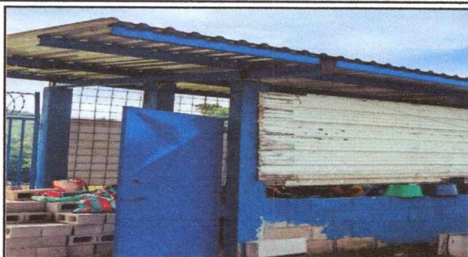
No.14 mantenimiento de puerta metalica en la cocina
