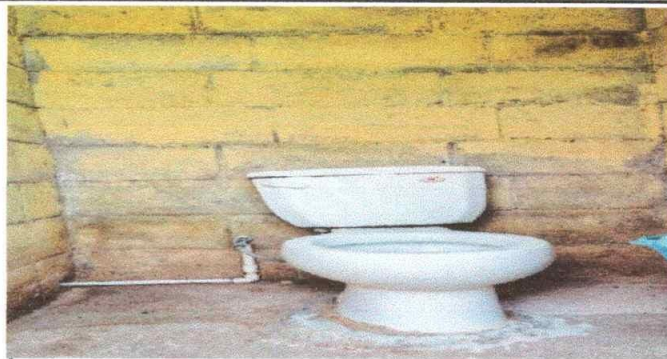
No.2 Mantenimiento preventivo de de inodoros de servicio sanitario
