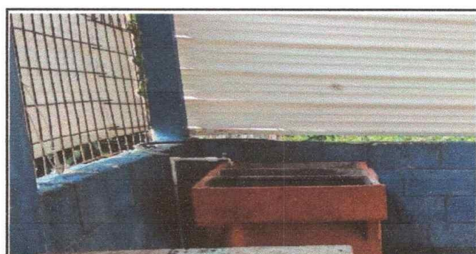
No.6 sustitución de pila con dos lavaderos
