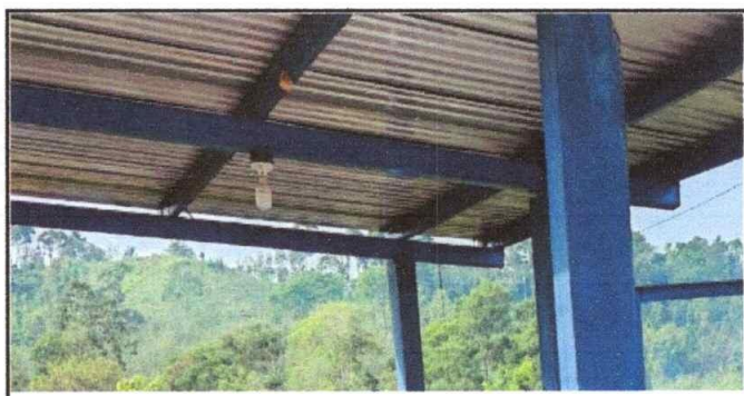
No.12 sustitución de luminaria en cocina
