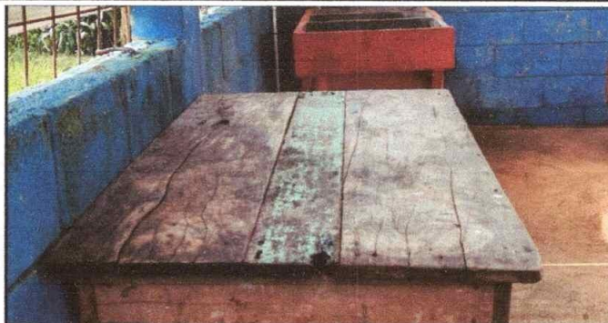
No.8 sustitución de mesa de concreto en cocina
