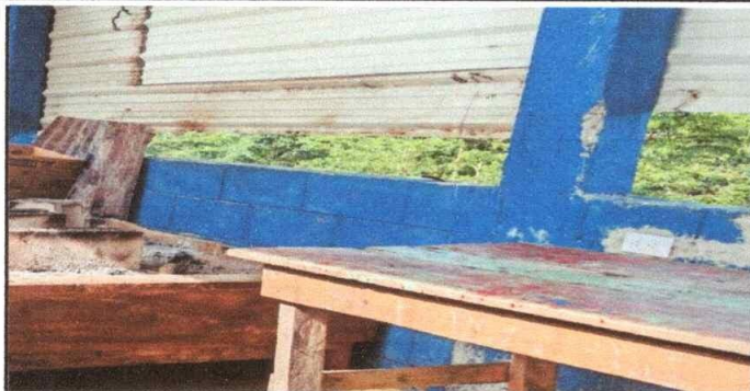
No.13 Sustitución de cable electrico + teberia PVC electrica en cocina
