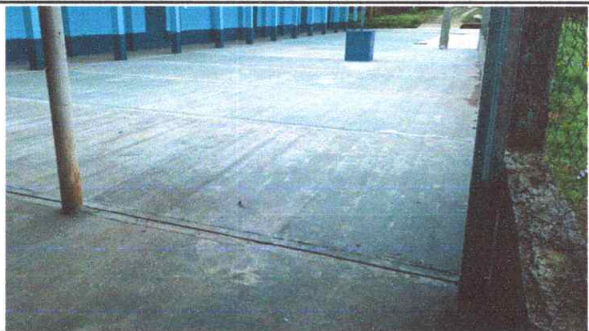
Suministro de materiales y mano de obra para la sustitución de piso firme de concreto dañado en área recreativa
