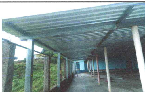
Sustitución de cubierta de lámina troquelada No.26
