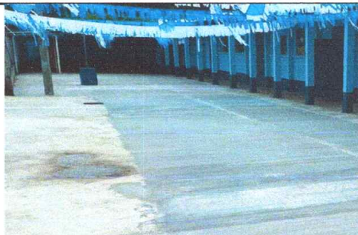
Suministro de materiales y mano de obra para la sustitución de piso firme de concreto dañado en área recreativa
