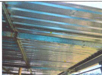
Sustitución de cubierta de lámina troquelada No.26
