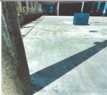
Suministro de materiales y mano de obra para la sustitución de piso firme de concreto dañado en área recreativa
