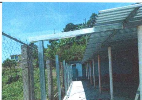
Sustitución de cubierta de lámina troquelada No. 26
