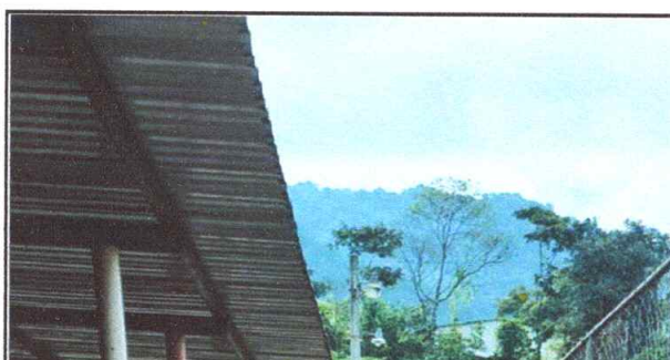
Sustitución de cubierta de lámina troquelada No. 26
