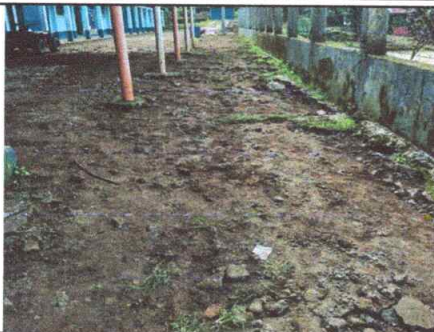
Suministro de mano de obra para la sustitución de piso firme de concreto de 7 centímetros de grosor en área recreativa
