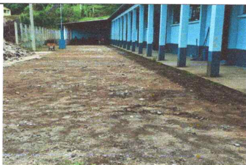
Suministro de mano de obra para la sustitución de piso firme de concreto de 7 centímetros de grosor en área recreativa
