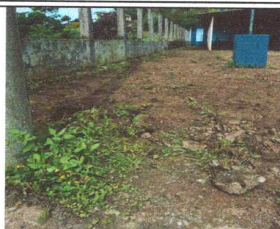
Suministro de mano de obra para la sustitución de piso firme de concreto de 7 centímetros de grosor en área recreativa
