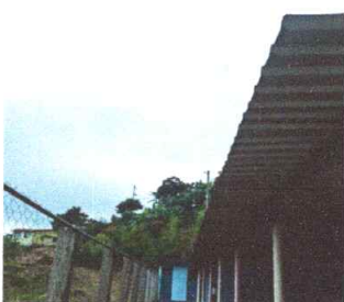
Sustitución de cubierta de lámina troquelada No. 26
