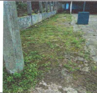
Suministro de materiales y mano de obra para la sustitución de piso firme de concreto dañado en área recreativa
