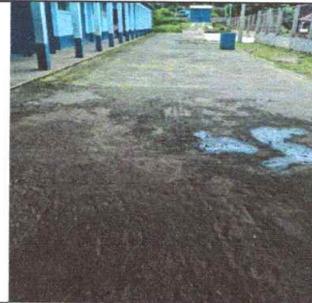
Sustitución de cubierta de lámina Consistente en. Sustitución de lámina troquelada # 26
