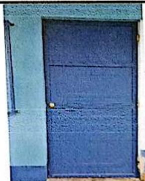
Foto 6: Sustrucción de puerta de lamina por puerta de metalica de 2.10 x 1.00
