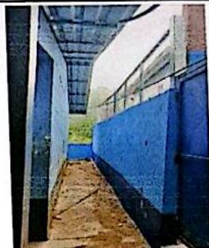
Foto 2: Mantenimiento correctivo de muro de retención de concreto de 30x1 x10
