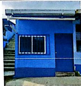
Foto 8: Sustrucción de balcon tipo reja en aula modulo 5 de 2 x 1 metros
