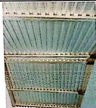
Foto 4: Sustrucción de cubierta de estructura de madera por estructura Metálica galvanizada en módulo 5
