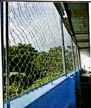
Foto 1: Sustrucción de reja perimetral de malla galvanizada de 2X2
