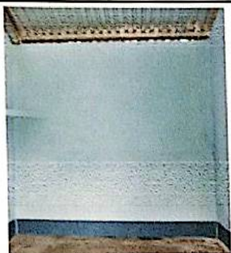
Foto 3: Sustrucción de paredes de lámina por pared de paneles prefabricados tipo durock para aula en módulo 5
