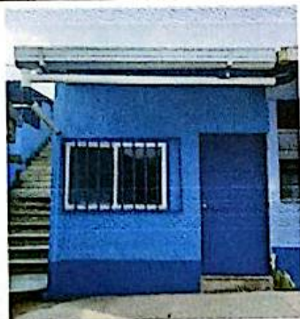
Foto 5: Sustrucción de cubierta De lámina troquelada Calibre 26 de aluzinc en aula módulo 5
