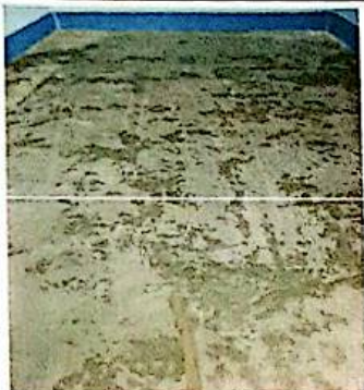
Foto 9: Sustrucción de piso firme de concreto de 7 cm de grosor en aula de modulo 5
