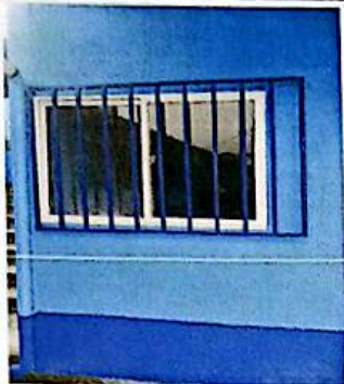
Foto 7: Sustrucción de ventana de lamina por ventana de pvc blanco con vidrio transparente de 5mm de 2 x 1 metros
