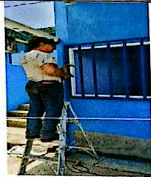
Foto 8: Sustitución de balcon tipo reja en aula modulo 5 de 2 x 1 metros
