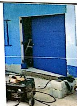
Foto 6: Sustitución de puerta de lamina por puerta de metalica de 2.10 x 1.00
