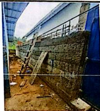
Foto 2: Mantenimiento correctivo de muro de retención de concreto de 30x1 x10
