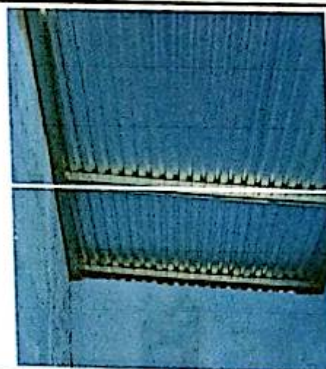
Foto 4: Sustitución de cubierta de estructura de madera por estructura Metálica galvanizada en módulo 5
