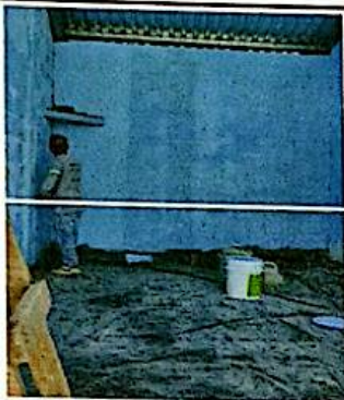
Foto 3: Sustitución de paredes de lámina por pared de paneles prefabricados tipo durock para aula en módulo 5
