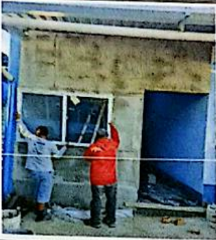
Foto 7: Sustitución de ventana de lamina por ventana de pvc blanco con vidrio transparente de 5mm de 2 x 1 metros
