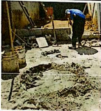
Foto 9: Sustitución de piso firme de concreto de 7 cm de grosor en aula de modulo 5
