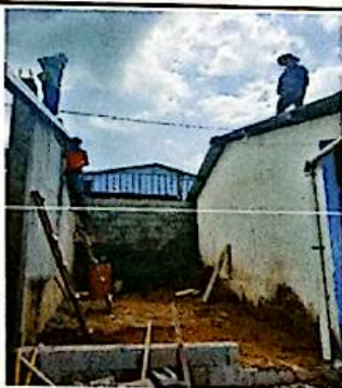
Foto 5: Sustitución de cubierta De lámina troquelada Calibre 26 de aluzinc en aula módulo 5
