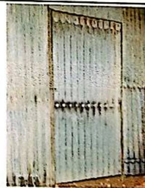
Sustitución de puerta de lámina por puerta metálica de 2.10 x1.00
