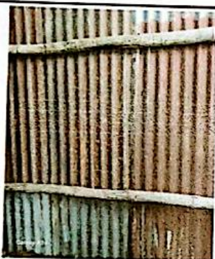
Sustitución de paredes de lámina por pared de paneles prefabricados tipo durock para aula en módulo 5
