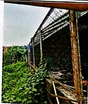
Sustitución de reja perimetral de malla galvanizada de 2x2"
