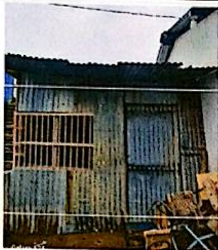
Sustitución de ventana de lámina por ventana de pvc blanco con vidrio transparente de 5mm 2x1 metros
