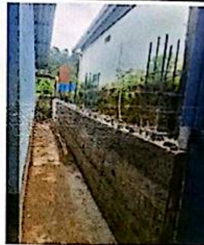
Mantenimiento correctivo de muro de retención de concreto de 30x1 x10
