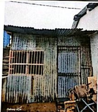
Sustitución de cubierta De lámina troquelada Calibre 26 de aluzinc en aula módulo 5
