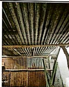
Sustitución de cubierta de estructura de madera por estructura Metálica galvanizada en módulo 5
