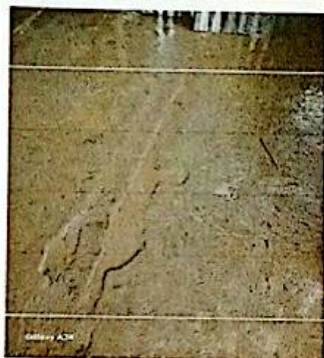
Sustitución de piso firme de concreto de 7 cm de grosor en aula de módulo 5.
