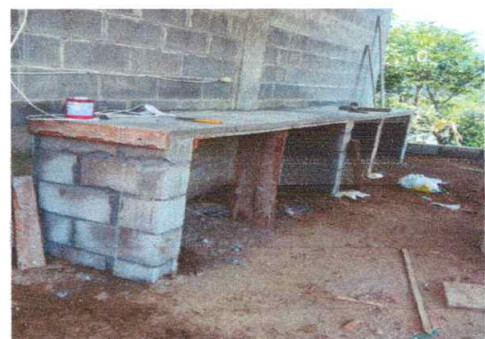
Sustitucion de mesa de trabajo de concreto Revestida con azulejo blanco en cocina.
