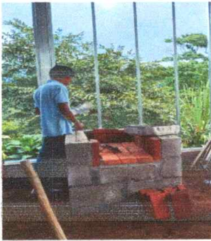
Sustitución de polleton en interior de cocina con una medida de 1.40 de a largo X 1 metro de ancho y 1 Metro de alto incluye plancha
