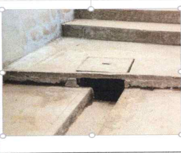
Sustitución de red de drenaje de agua pluvial y con tubería de 8 pulgadas y 3 pulgadas para desagüe de pila con su respectiva caja de registro de 90 x 90 de ancho .
