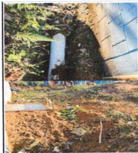
Sustitución de red de drenaje de agua pluvial y con tubería de 8 pulgadas y 3 pulgadas para desagüe de pila con su respectiva caja de registro de 90 x 90 de ancho .
