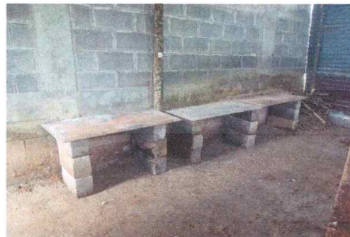
Sustitución de mesa de trabajo de concreto Revestida con azulejo blanco en cocina.
