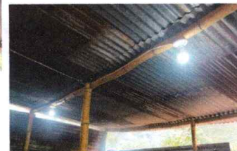
Sustitución de red eléctrica de iluminación con luminarias e interruptores en interior de cocina.
