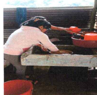
Sustitución de pila de concreto de 2 lavaderos en interior de cocina.
