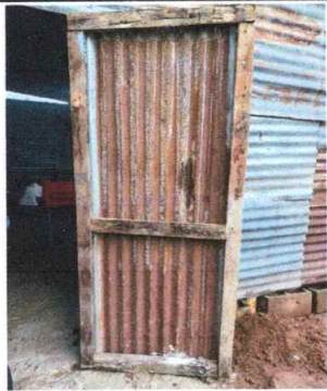
Sustitución de puerta de metal Consistente en puerta Metálica de 1 metro de ancho x 2.10 de alto con chapa para la cocina.
