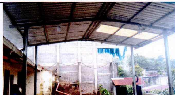
Foto 3: Sustitución de Cable Electrico #12 para sistema de Iluminación
