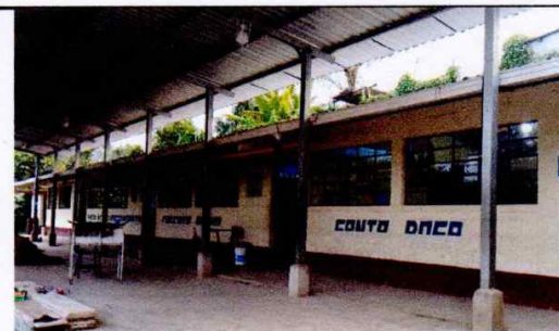
Foto 6: Sustitución de Vidrios y Mantenimiento de Ventanales
