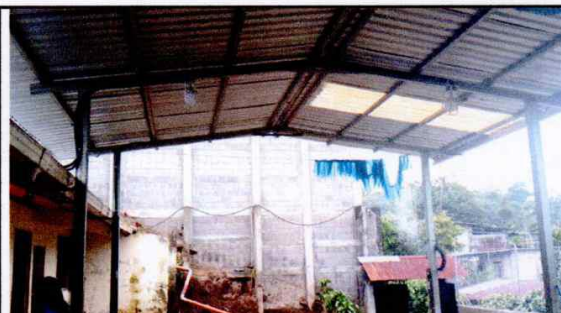
Foto 4: Sustitución de Lamparas en Salón de usos múltiples
