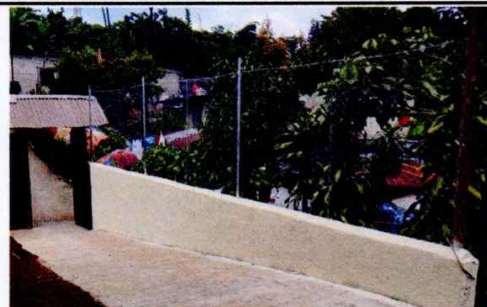
Foto 2: Sustitución de cerca de lamina por malla y tubo galvanizado
