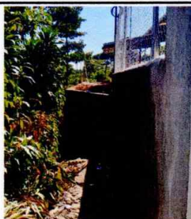
Foto1: Sustitución de Muro de contención perimetral
