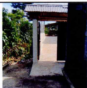
Foto 5: Reparación de Entrada y Paso Peatonal
