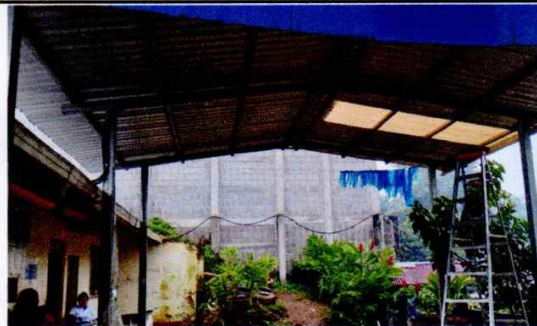
Foto 4: Sustrucción de Lamparas en Salón de usos múltiples
