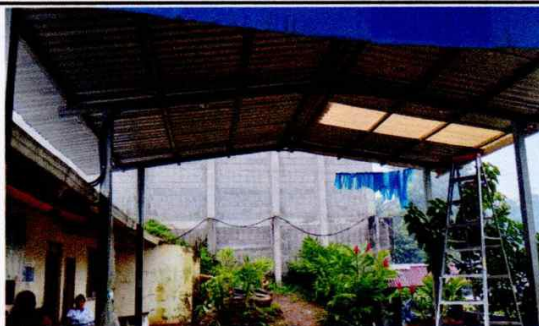
Foto 3: Sustrucción de Cable Electrico #12 para sistema de Iluminación
