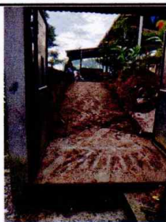
Foto 5: Reparación de Entrada y Paso Peatonal
