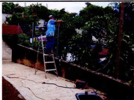
Foto 2: Sustrucción de cerca de lamina por malla y tubo galvanizado
