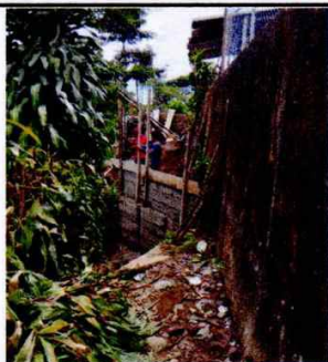
Foto 1: Sustrucción de Muro de contención perimetral
