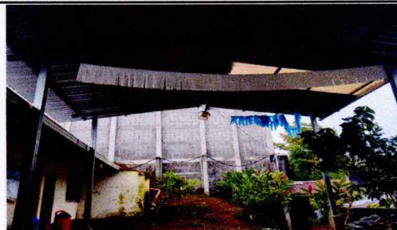
No.4 Sustitución de Lamparas en Salon de usos multiples
