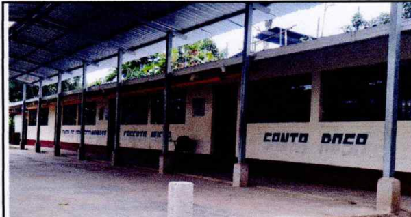
No.6 Sustitucion de Vidrios y Mantenimiento de Ventanales
