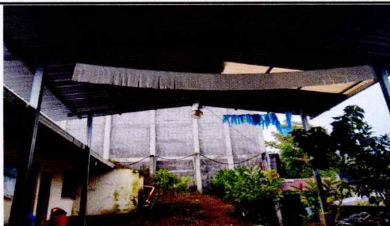
No.3 Sustitucion de Cable Electrico #12 para Sistema de Iluminación
