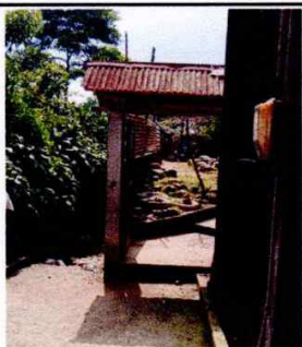
No.5 Reparacion de Entrada y Paso Peatonal
