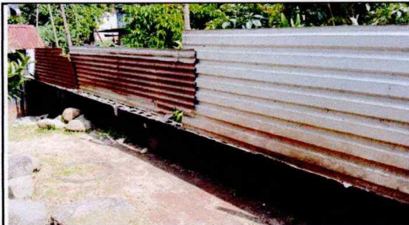
No.2 Sustitución de cerca de lamina por maya y tubo galvanizado
