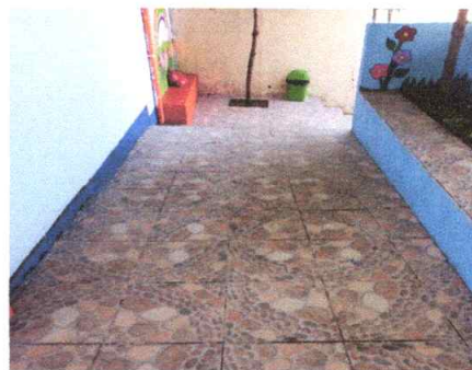
No.2 Reparación de piso con cerámico antideslizante
