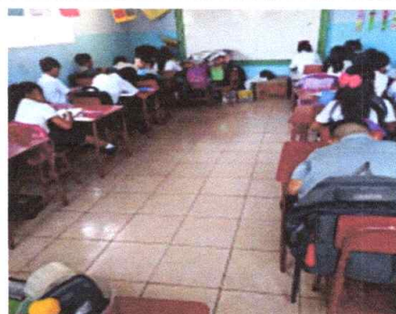
No.7 Reparación de piso de aula 1 y 2 con cerámico de 30 * 30
