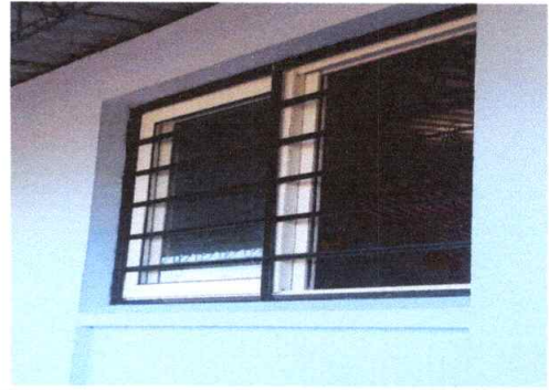
No. 9 Sustitución de balcones metálicos
