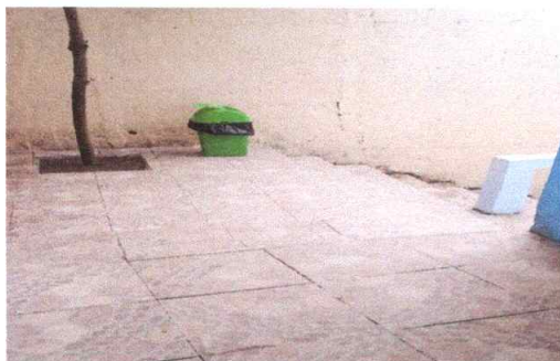
No.5 Sustitución de piso de concreto en gradass
