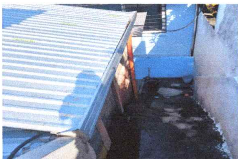
No.3 Sustitucion de canal pluvial
