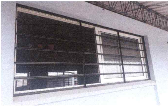
No. 9 Sustitución de balcones metálicos
