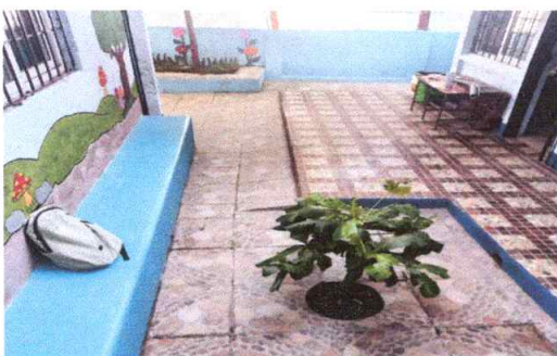
No.2 Reparación de piso con cerámico antideslizante
