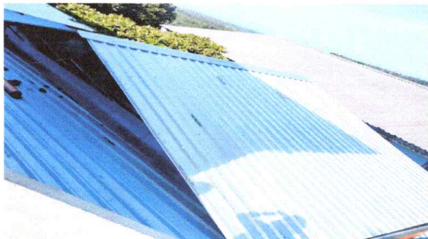
No.1 Sustitución de cubierta metálica con lámina troquelada
