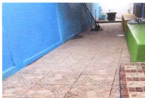
No.2 Reparación de piso con cerámico antideslizante
