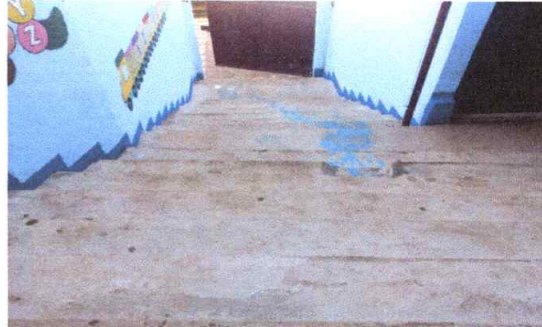
No.6 Reparación de gradass huella y contra huella, piso rustico + tallado de grada
