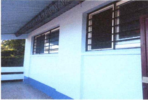
No.8 Sustitución de ventanales por ventanas de pvc corredizas con vidrio claro de 0.05 mm
