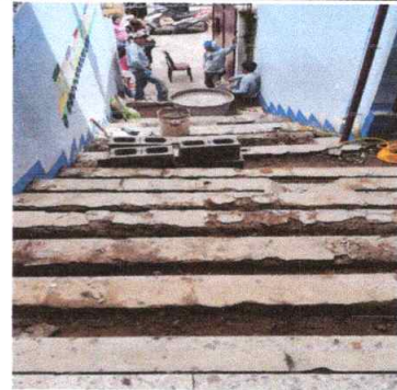
No.6 Reparación de gradass huella y contra huella, piso rustico + tallado de grada
