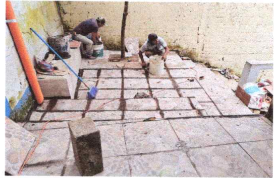
No.2 Reparación de piso con cerámico antideslizante
