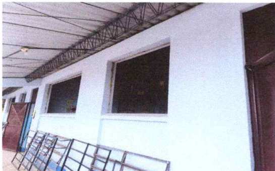
No.8 Sustitución de ventanales por ventanas de pvc corredizas con vidrio claro de 0.05 mm
