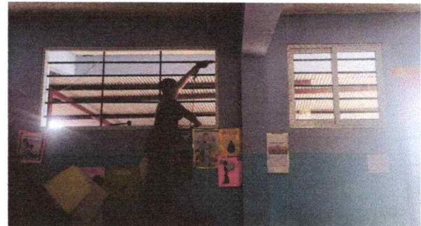
No.8 Sustitución de ventanass por ventanass de pvc corredizas con vidrio claro de 0.05 mm
