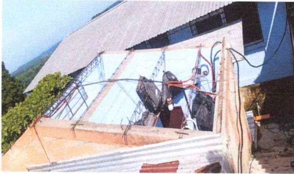
No.1 Sustitución de cubierta metálica con lámina troquelada
