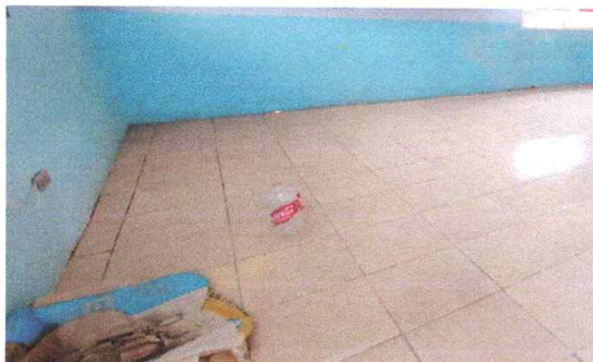
No.7 Reparación de piso de aula 1 y 2 con cerámico de 30 * 30
