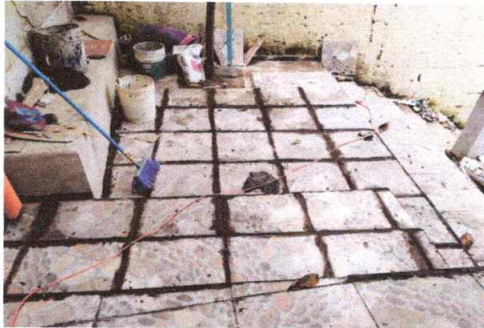
No.5 Sustitución de piso de concreto en gradass
