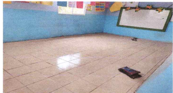
No.7 Reparación de piso de aula 1 y 2 con cerámico de 30 * 30
