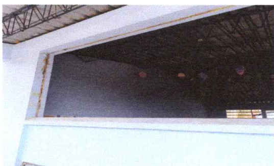
No. 9 Sustitución de balcones metálicos
