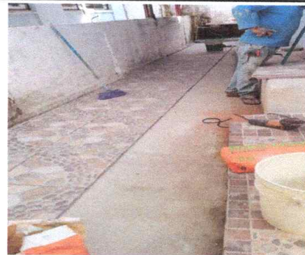
No.2 Reparación de piso con cerámico antideslizante
