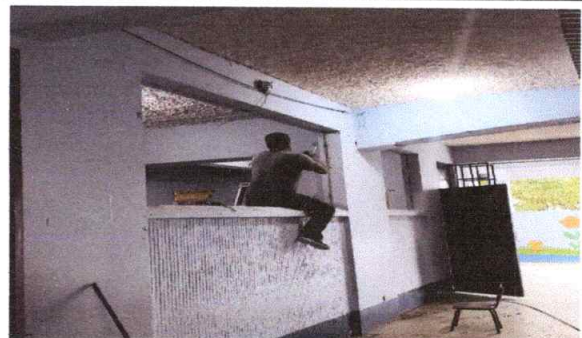
No.8 Sustitución de ventanass por ventanass de pvc corredizas con vidrio claro de 0.05 mm
