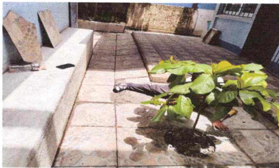
No.2 Reparación de piso con cerámico antideslizante
