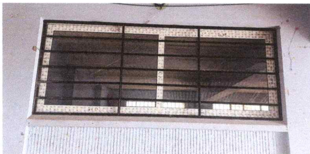
No.8 Sustitución de ventanass por ventanass de pvc corredizas con vidrio claro de 0.05 mm
