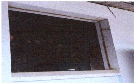
No. 9 Sustitución de balcones metálicos
