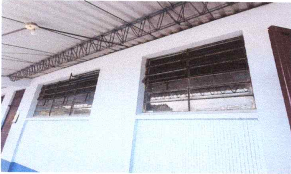
No.8 Sustitución de ventanales por ventanas de pvc corredizas con vidrio claro de 0.05 mm
