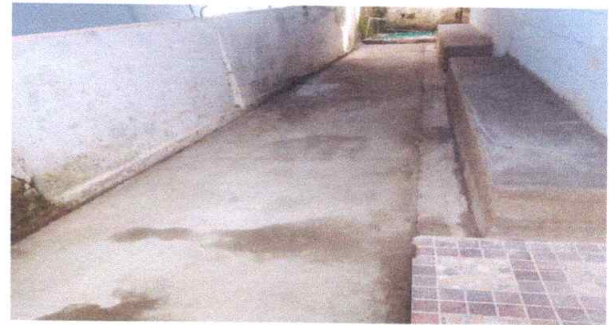
No.2 Reparación de piso con cerámico antideslizante
