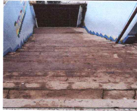
No.6 Reparación de gradass huella y contra huella, piso rustico + tallado de grada
