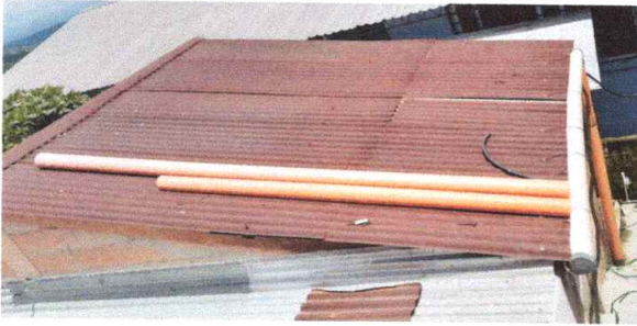
No.1 Sustitución de cubierta metálica con lámina troquelada
