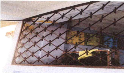
No. 9 Sustitución de balcones metálicos
