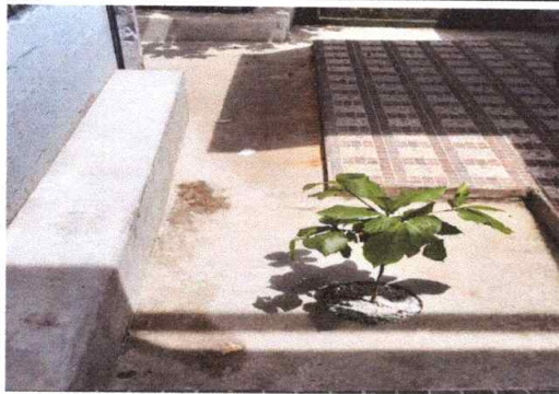
No.2 Reparación de piso con cerámico antideslizante
