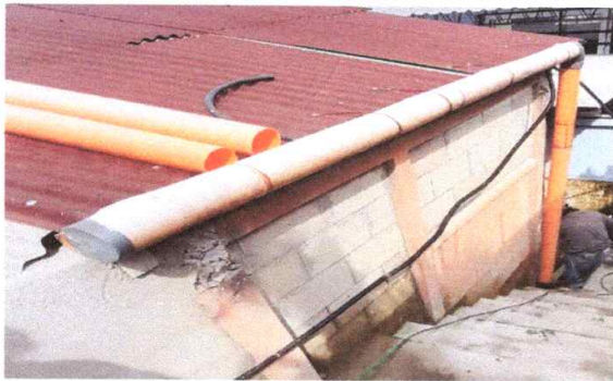
No.3 Sustitucion de canal pluvial
