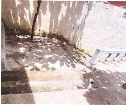
No.5 Sustitución de piso de concreto en gradass
