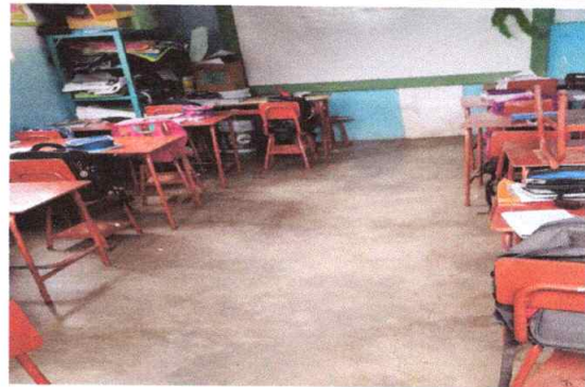
No.7 Reparación de piso de aula 1 y 2 con cerámico de 30 * 30
