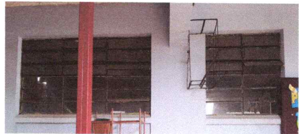
No.8 Sustitución de ventanales por ventanas de pvc corredizas con vidrio claro de 0.05 mm
