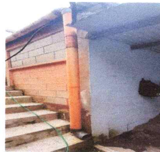
No.4 Sustitución de bajadas pluviales
