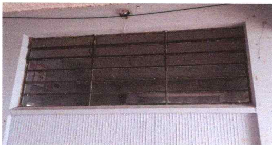
No.8 Sustitución de ventanales por ventanas de pvc corredizas con vidrio claro de 0.05 mm
