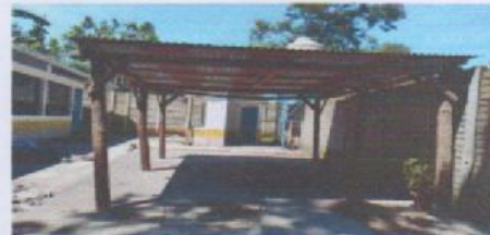
Foto 2: Sustrución de cubierta metálica con lámina troquelada calibre 26.
