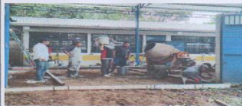
Foto 4: Reparación de torta de concreto en patio,
