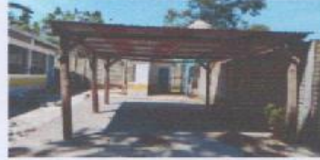
SUSITUCIÓN DE CUBIERTA METALICA CON LAMINA TROQUELADA CALIBRE 28
