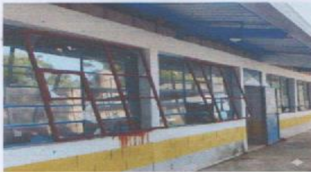
Reparación de ventanas con balcones.
