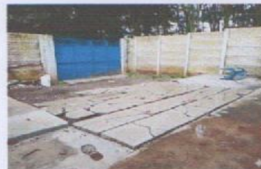
REPARACIÓN DE TORTA DE CONCRETO EN PATIO
