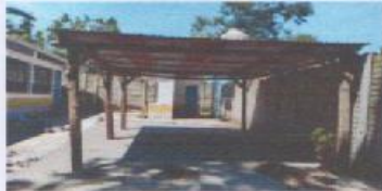
SUSTITUCIÓN DE ESTRUCTURA POR ESTRUCTURA METALICA CON COSTANERA DE 6'2 DOBRE
