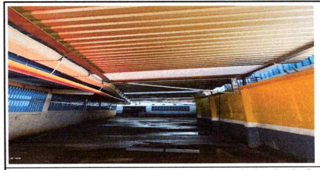
Foto 6: Sustrucción de estructura metalica de tubo cuadrado galvanizado 2x2 chapa 16
