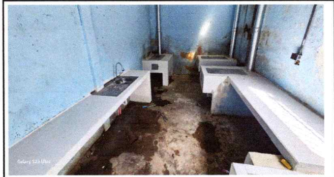
Foto 4: Reparación de mesas de trabajo, azulejo y estufa de cocina.
