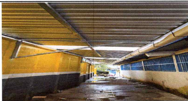
Foto 7: Sustitución de cubierta de lamina troquelada calibre 26
