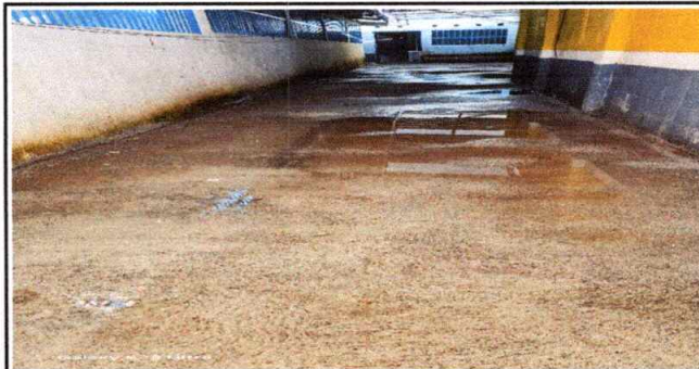
Foto 8: Sustitución de piso de concreto en patio.
