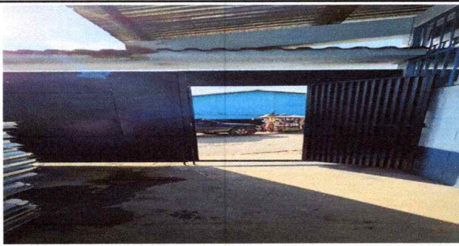
Foto1: Sustrucción de portón metalico.
