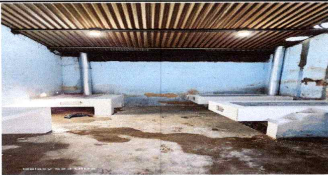
Foto 3: Reparación de estufas de cocina con ladrillo, chimenea y azulejo.
