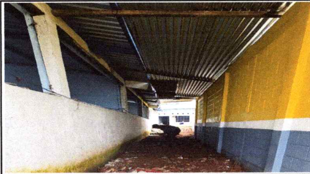
Foto 8: Sustitución de piso de concreto en patio.
