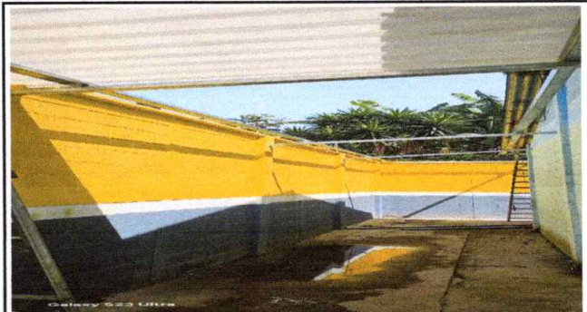
Foto 2: Sustrucción de cubierta de lámina troquelada de policarbonato calibre 26
