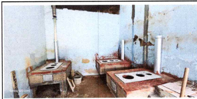
Foto 3: Reparación de estufas de cocina con ladrillo, chimenea y azulejo.
