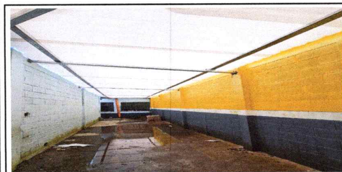
Foto 5: Sustrucción de canales para agua pluvial.
