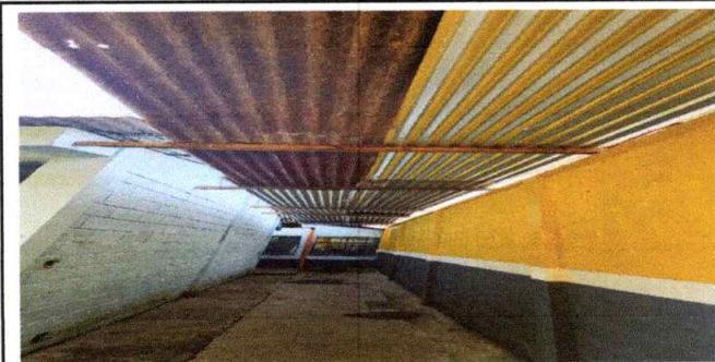
Foto 5: Sustrucción de canales para agua pluvial.
