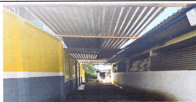
Sustitución de cubierta de lamina troquelada calibre 26
