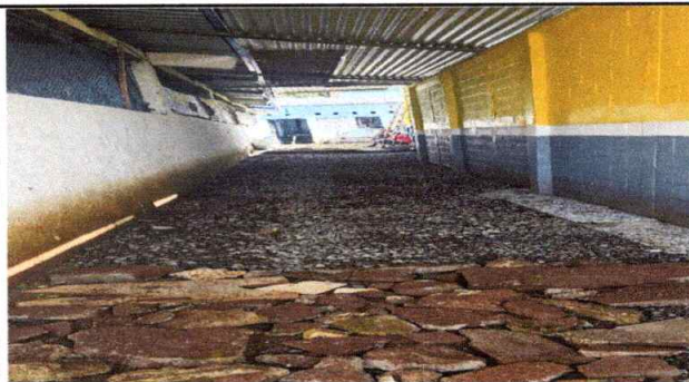
Sustitución de piso de concreto en patio.
